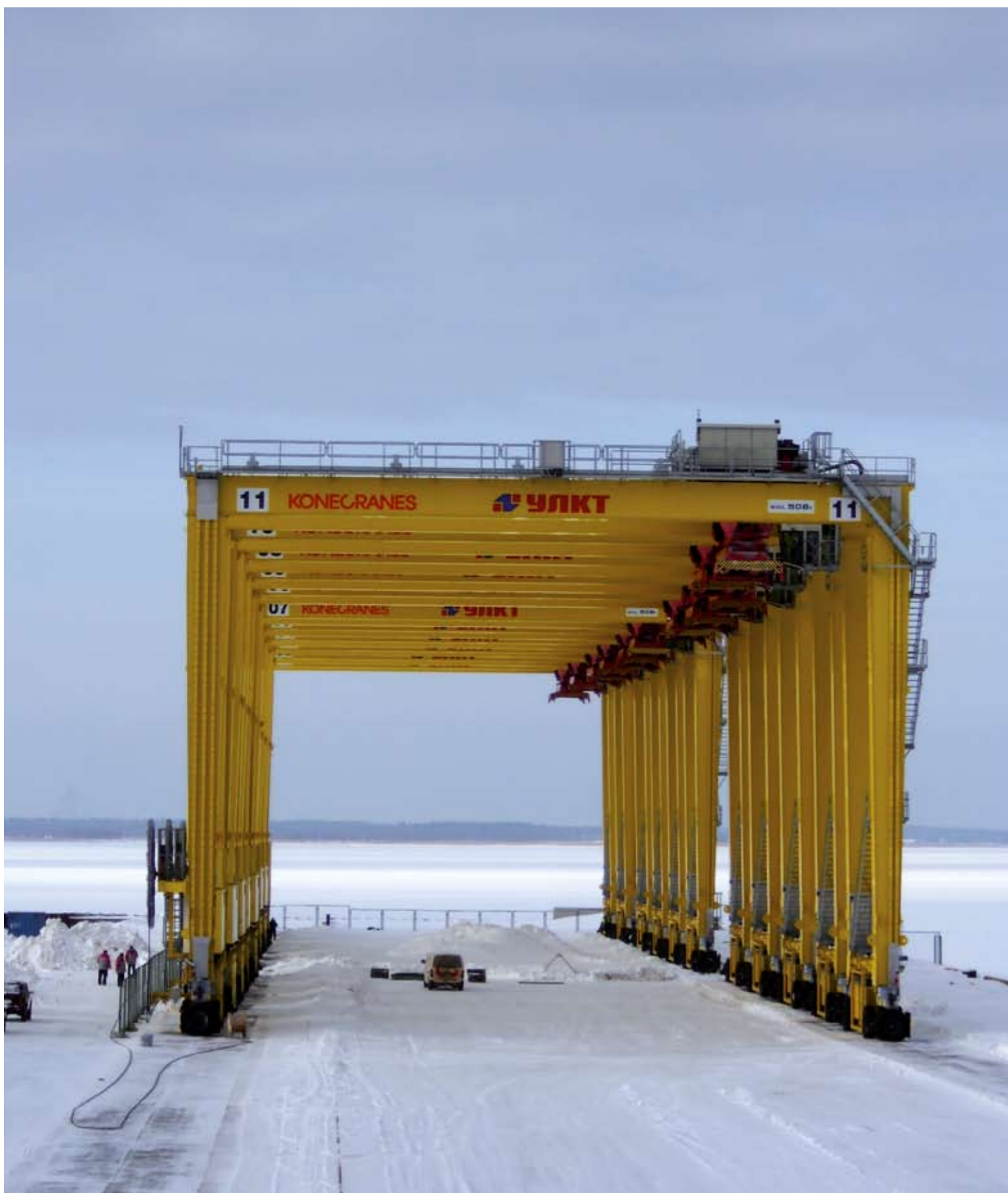
OJSC Ust.-Luga Container Terminal, Russland
