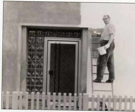
Unser Haus nimmt Formen an. Ein großer Schritt ist getan, der Rohbau steht.
