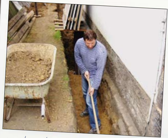
Knochenarbeit: Viel Boden musste für das neue Fundament ausgehoben werden.
