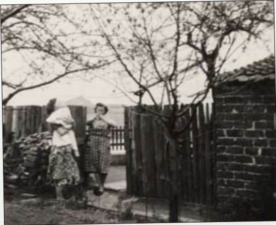
Die Nachbarskinder sind neugierig. Unsere Baustelle lädt sie zum spielen ein.
