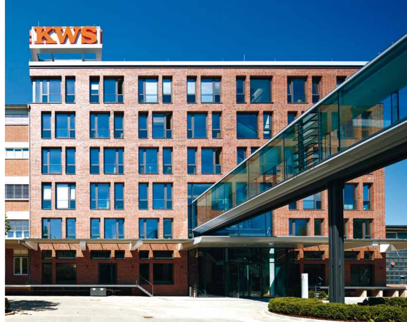
Neue Büroräume für 120 Mitarbeiter: Mit dem Umbau unseres alten Speichers wurde eines der energieeffizientesten Gebäude Deutschlands geschaffen und vom Bundesministerium für Wirtschaft und Technologie dafür ausgezeichnet.
