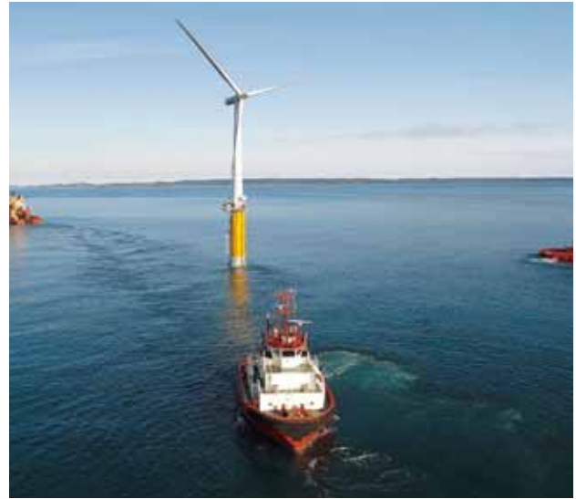
fertigten und auslieferten, die im Jahr 2009 vor der norwegischen Küste in einer Wassertiefe von 220 Metern freischwimmend verankert wurde – der Beginn eines neuen Zeitalters in der Windenergie (siehe auch Seite 28).
