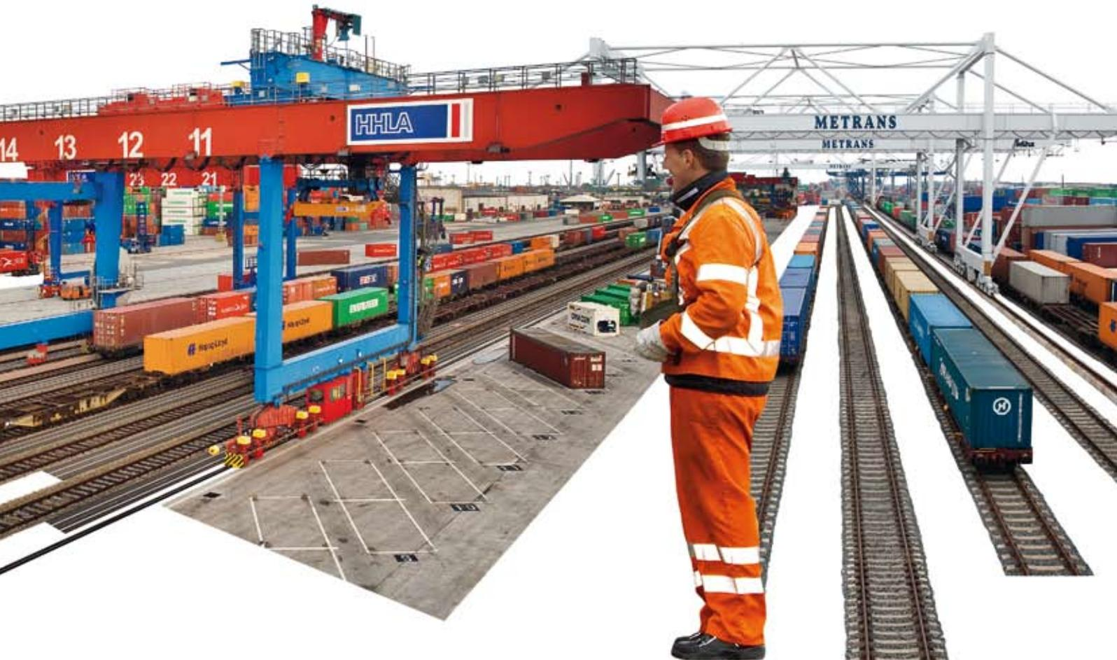
■ In Praha-Uhřetěves, vor den Toren der Prager Südstadt, winden sich auf einem lang gestreckten Gelände zwölf Kilometer Schienenstränge. Bis zu 25.000 Standardcontainer lagern hier gleichzeitig. In dem Labyrinth aus bunten Stahlklötzen bewegen drei Containerbrücken die Boxen für den Export, drei weitere für den Import. Die HHLA Tochter Metrans betreibt diese Anlage, die zu den größten Binnenterminals Europas gehört, seit 1992.
