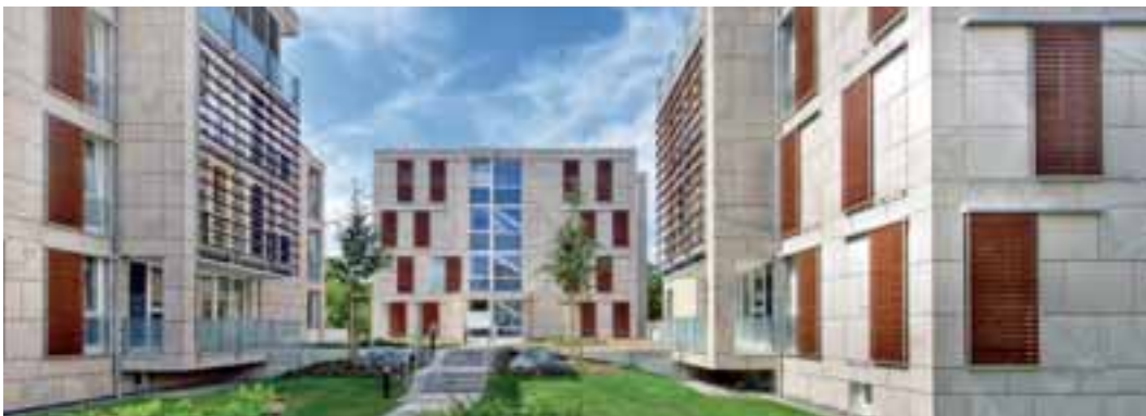
Stadtvillen in Braunschweig mit vorgehängter hinterlüfteter Fassade (StoVerotec Stone Massive mit Sto-Sandstein Neubrunn)
