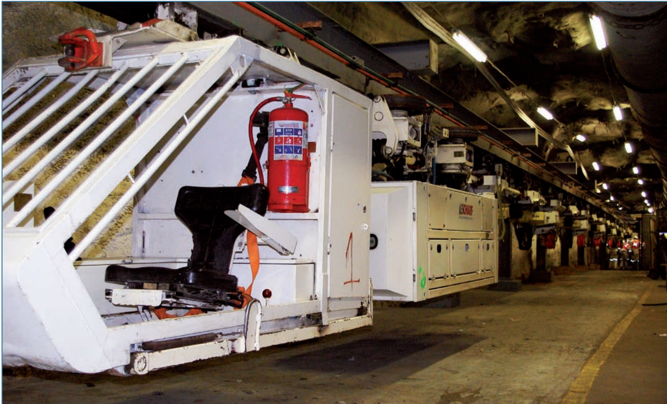
Elektrisch direkt angetriebene Einschienenhängebahn (EMTS)
