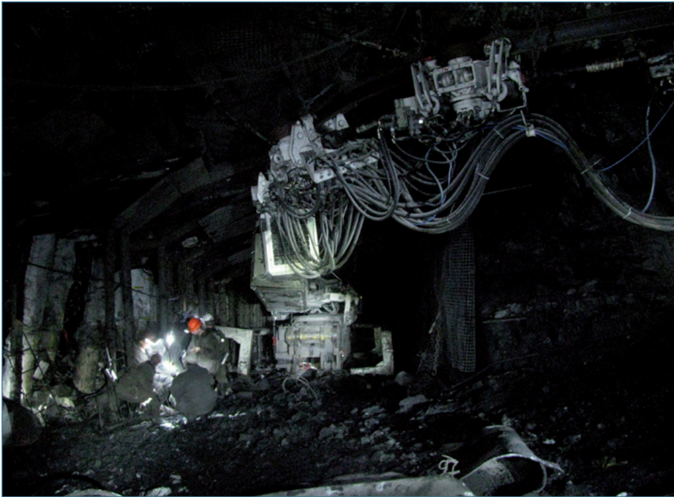
Einschienehängbahn beim Strebuzug
