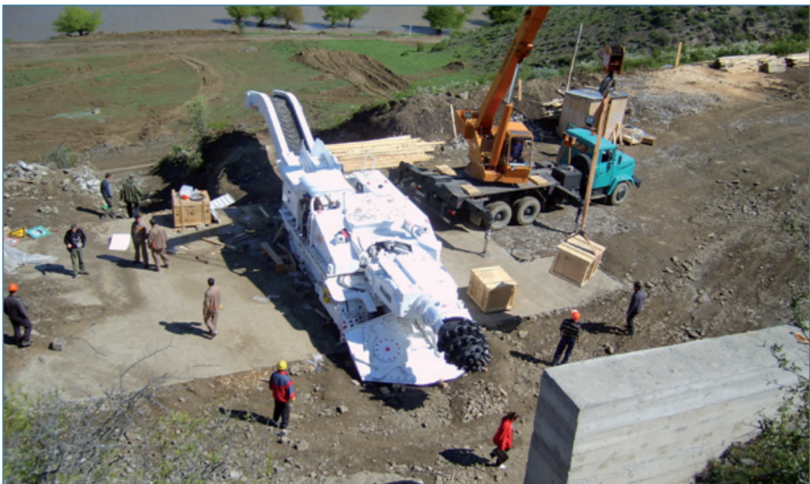
Vorbereitung einer Teilschnittmaschine zum Einsatz
