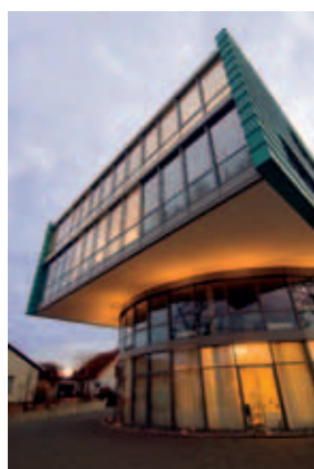
OSNABRÜCK SUTTHAUSER STRASSE
