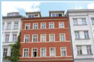
Dresdener Straße 662 Wohneinheiten vor 1918
