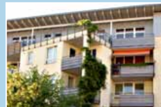
Schillerstraße 306 Wohneinheiten 1990er Jahre
