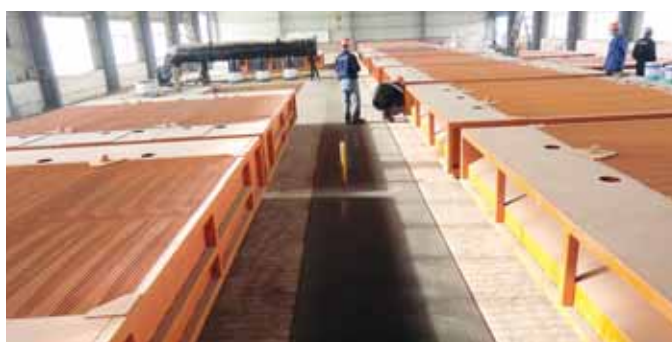
Bauarbeiten am Ringofen im Werk Yangquan, China.
