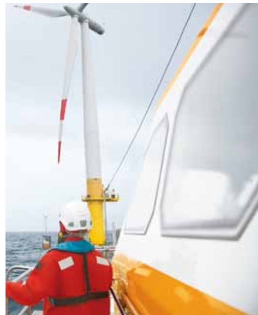
OBEN – Mit EnBW Baltic 1 realisierte die EnBW mit Siemens-Anlagen den ersten kommerziellen Offshore-Windpark Deutschlands. Die 21 Windenergieanlagen mit einer Gesamtleistung von 48,3 MW stehen rund 16 km nördlich von Zingst auf der Halbinsel Darß in der Ostsee.
