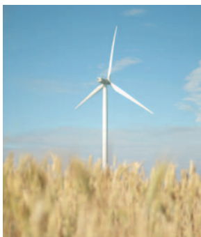
Ferme Eolienne de Chéry, Frankreich
