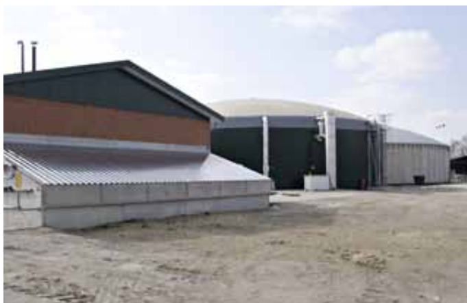
Neben der 500 kW-starken Anlage setzt Ronnebaum mit einer 637 kW-Neuanlage von EnviTec auf die Regelenergie.
