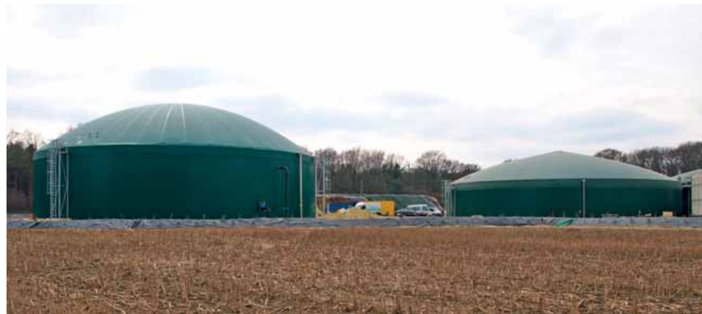
Das Gute noch besser machen: die Menge des speicherbaren Energieträgers Biomethan lässt sich durch Tragluftdächer erheblich steigern.
