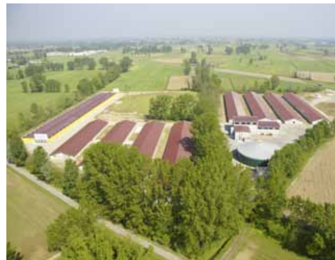
Bereits seit Oktober 2010 in Betrieb: die 250 kW-starke Kleinanlage in der italienischen Provinz Cremona.
