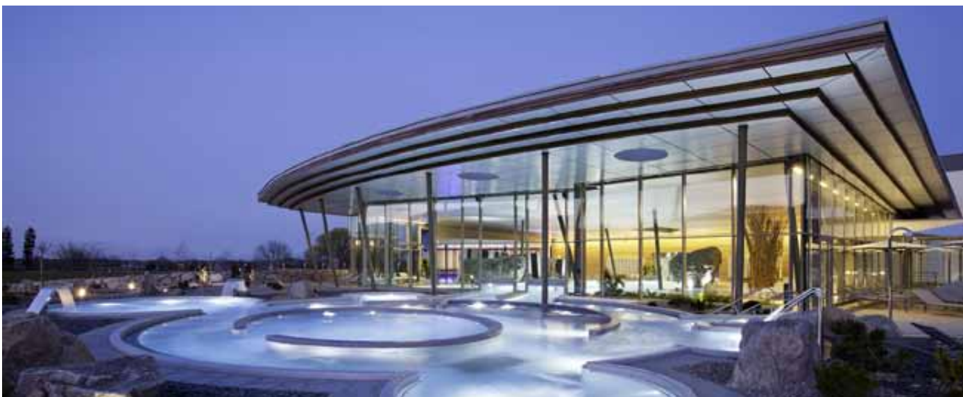
Wellness dank grüner Wärme: die 1415 kW-starke Biogasanlage in Ribeauvillé versorgt unter anderem das Spa eines Hotels.
