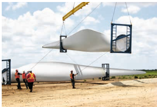
Service und Wartung sind eine wichtige Dienstleistung bei Windkraftanlagen.
