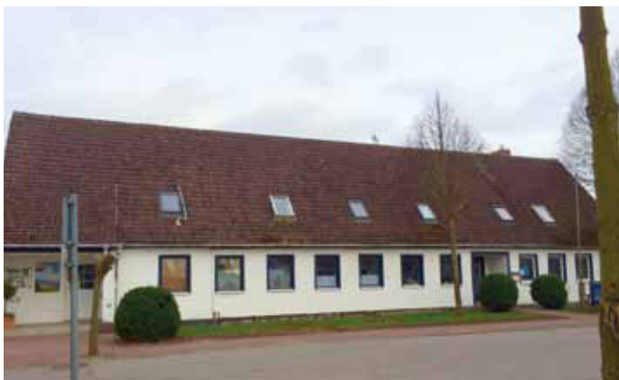
Jetziges Rezeptionsgebäude in Boltenhagen
