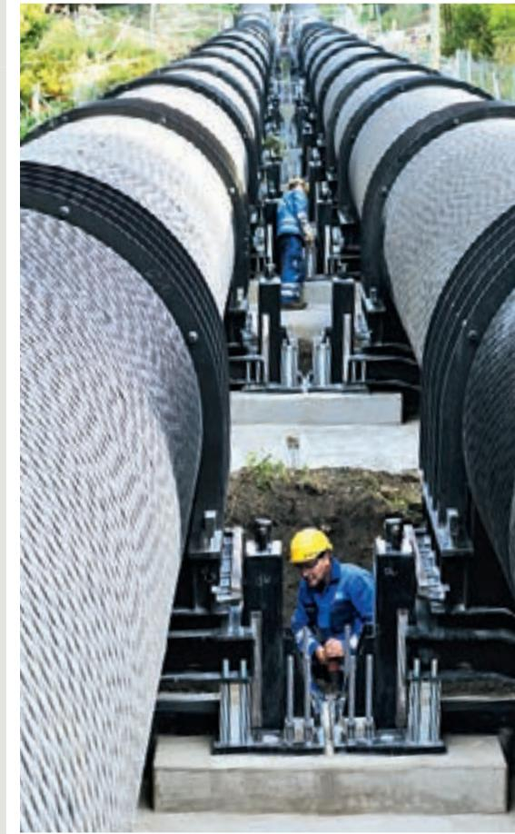
50.000 Liter Wasser pro Sekunde werden durch die erneuerte Druckrohrleitung ins Krafthaus von Malgovert stürzen. Vor der Übergabe überprüfen Vertreter des Auftraggebers EDF alle Rohrverbindungen peinlichst genau. Innovative Lager von Bilfinger stellen sicher, dass die Leitung trotz geologischer Bewegungen am Steilhang auf Jahrzehnte hinaus funktionieren wird.
