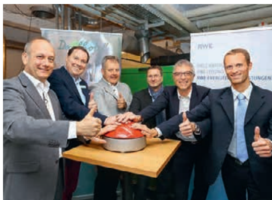
Inbetriebnahme des neuen Blockheizkraftwerks im Dorffhotel Sylt
