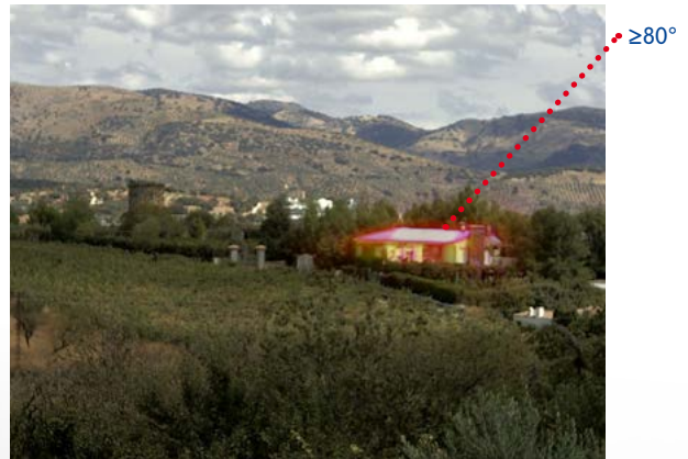
„Overlay“ • Überlagerung des Thermal- und des optischen Bildes
