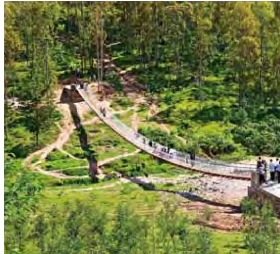
Einfache Fußgängerbrücken erleichtern das Leben vieler Menschen in abgelegenen Regionen der Welt. Gerade in der Regenzeit würden sie sonst von wichtigen Zielen abgeschnitten sein. 2015 haben HOCHTIEF-Mitarbeiter in Nicaragua (Jocote Arriba, links) und Ruanda (Muguba, rechts) Brücken errichtet. (Nicht im Bild ist das Projekt El Pueblito, Nicaragua.)
