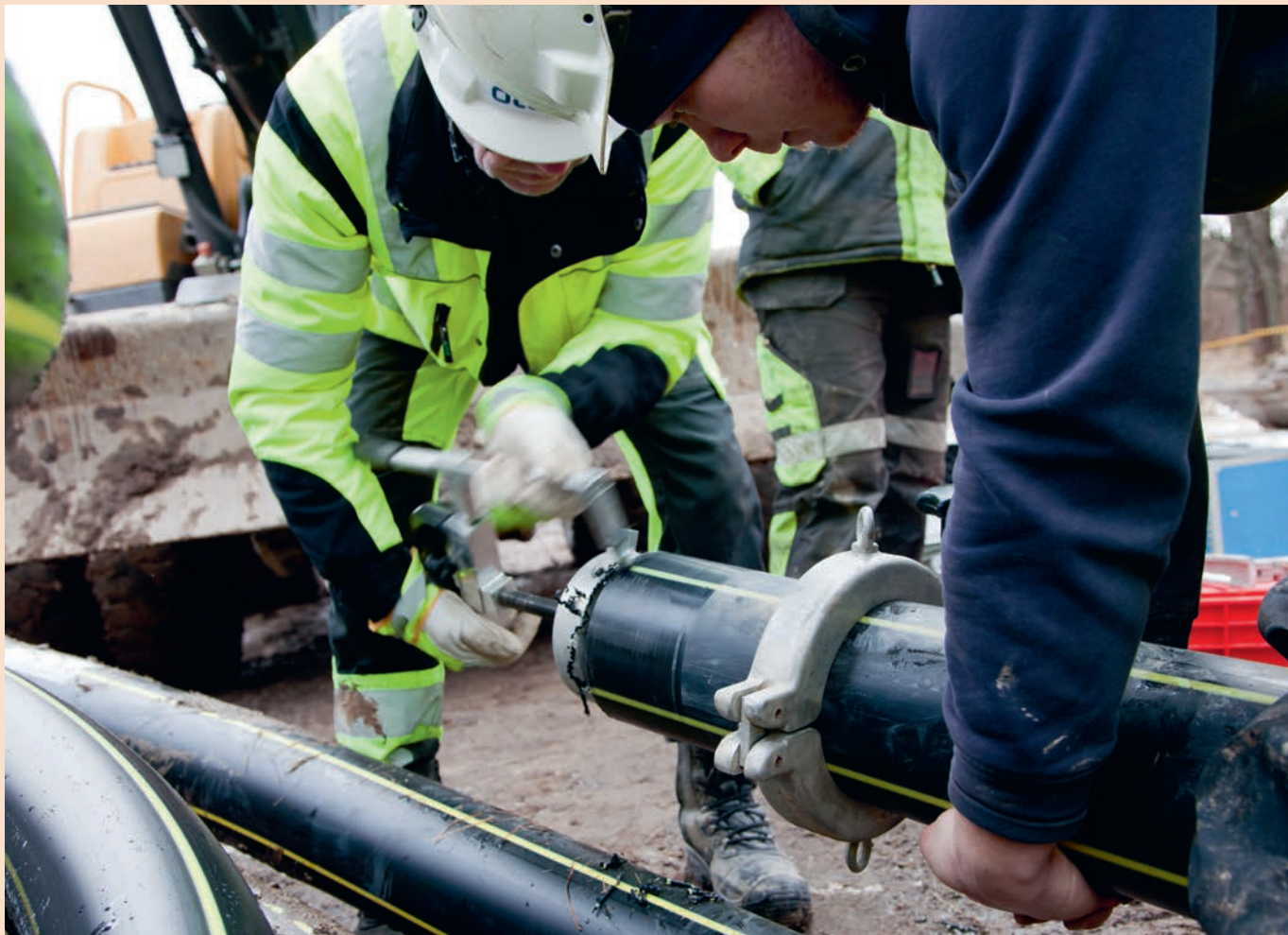
Neue Verlegetechnik für Hochspannungsleitungen unter der Erde
