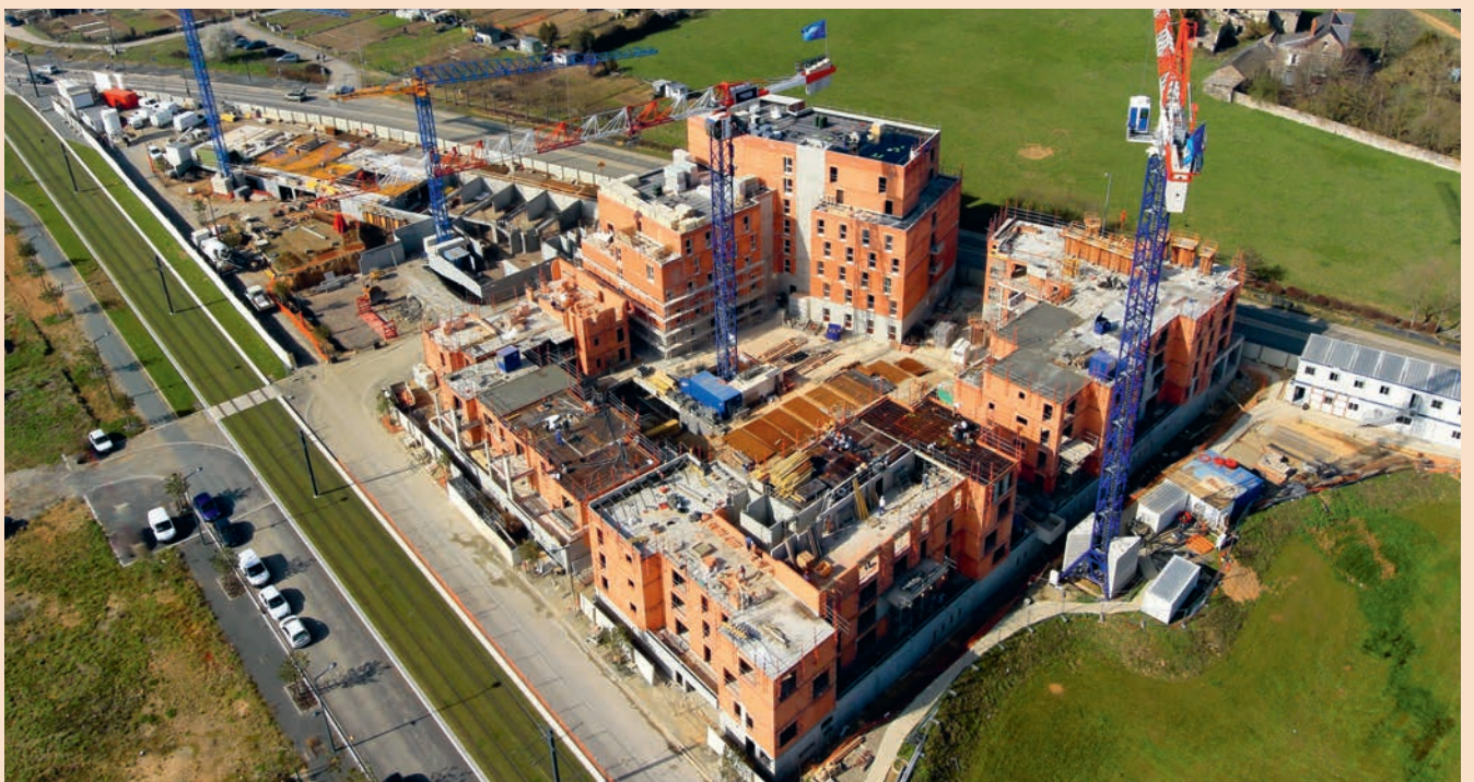
Schallgeschützte Bauweise schafft Wohnraum zwischen Schnellstraße und Straßenbahn
