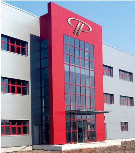
Das Betriebsgebäude der POLYTEC in Tianjin kurz vor seiner Eröffnung
