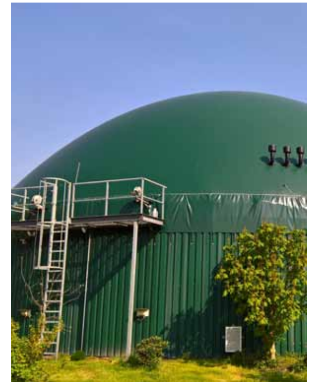
Eine Erhöhung des Gasspeichervolumens z.B. durch ein Tragluftdach ist notwendige Voraussetzung zur Teilnahme an der Direktvermarktung.
