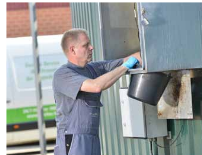
Immer direkt vor Ort: Das EnviTec Service-Team im Einsatz.
