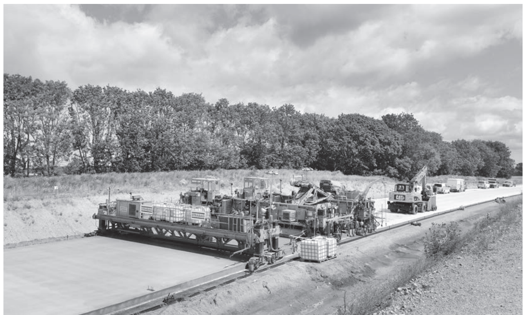
Tief-, Straßen- und Erdbauarbeiten B96n, Samtens, Rügen
