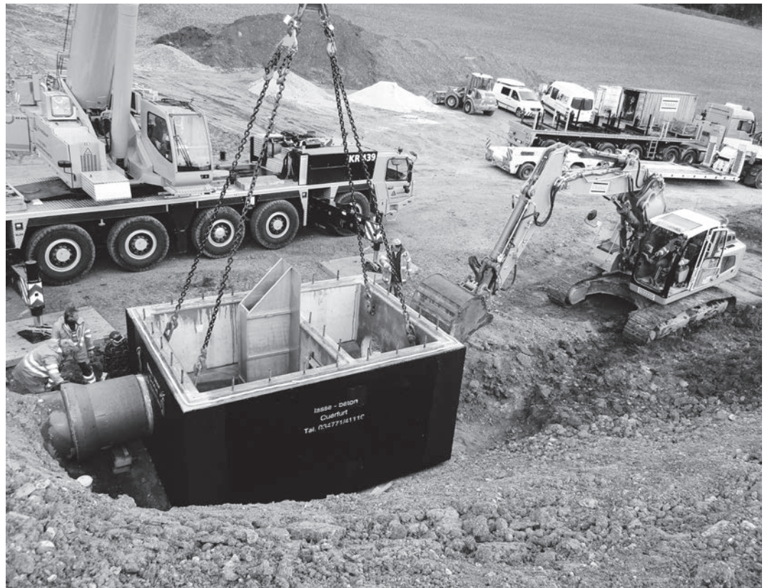
Neubau Hochwasserrückhaltebecken, Reifenthal
