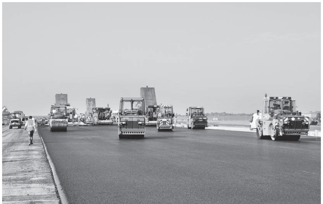
Flughafen BER – Sanierung der Start- und Landebahn Nord
