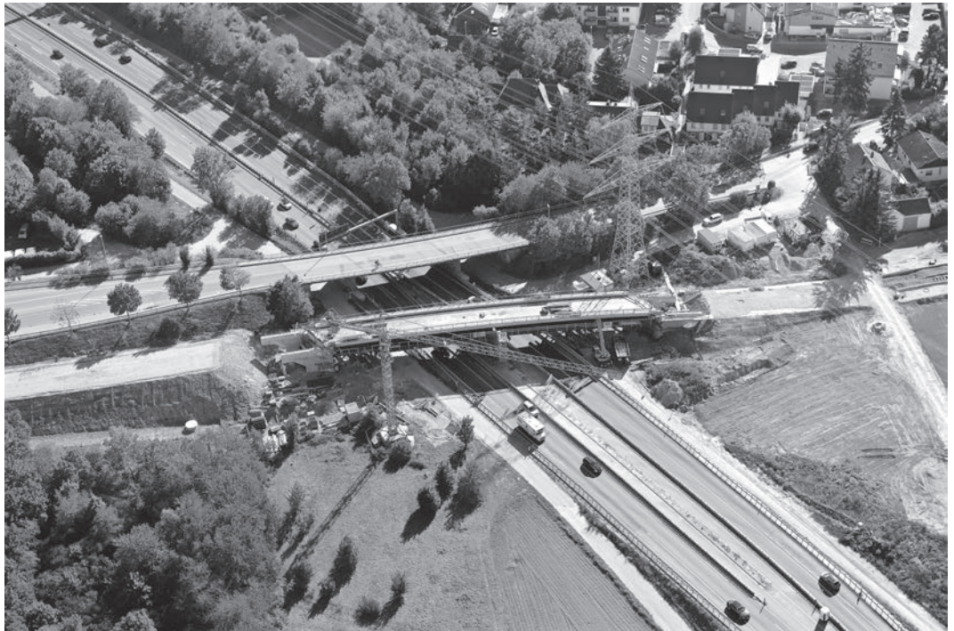
Neubau Straßenbahnbrücke, Mainzelbahn, Mainz
