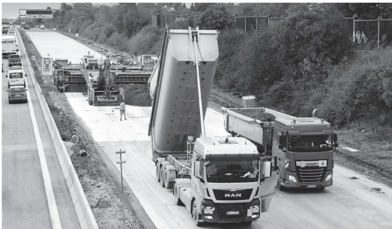
BAB 5 bei Eppelheim, grundlegende Erneuerung in Betonbauweise
