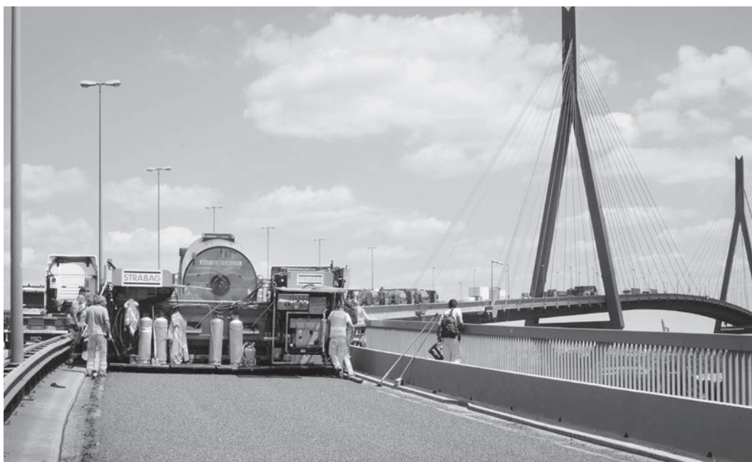
Abdichtung Ost- und Westrampe Köhlbrandbrücke, Hamburg
