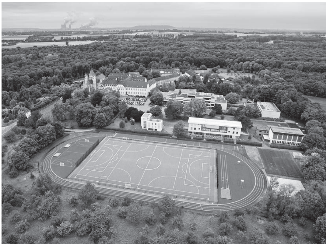
Sanierung und Erweiterung Schulsportanlage Norbert-Gymnasium, Dormagen
