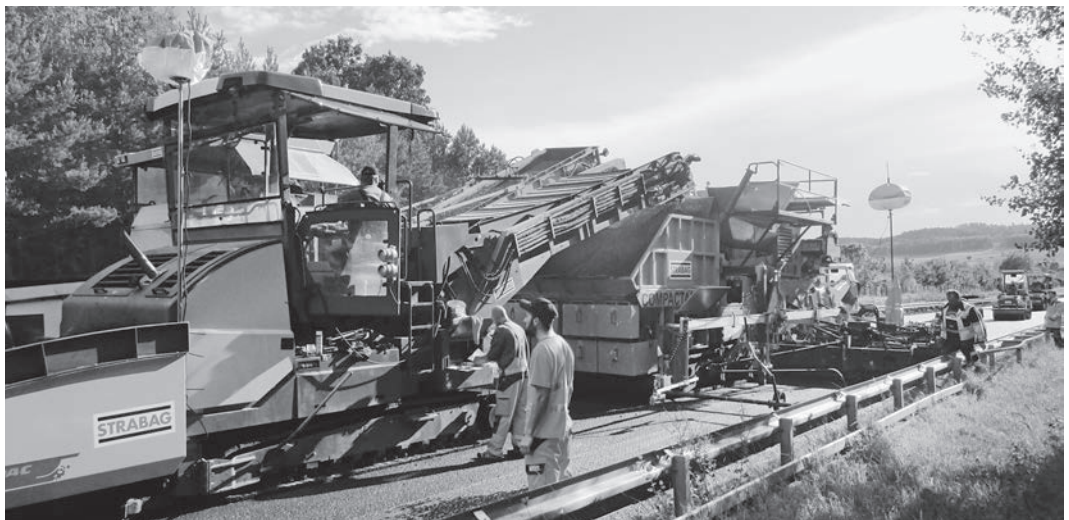
BAB 49 Borken-Neuental, Kompaktasphalt
