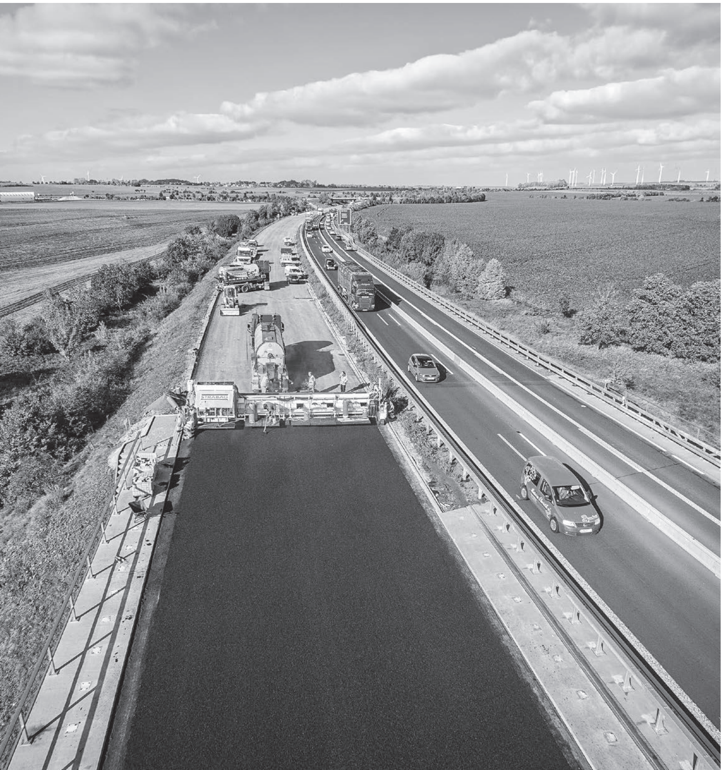
BAB 14 Halle-Tornau-Plötzkau, Gussasphaltarbeiten
