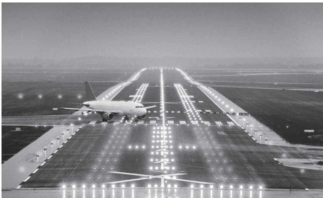
Flughafen BER – Sanierung der Start- und Landebahn Nord
