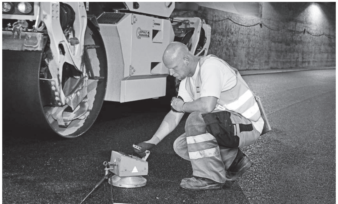
Wallringtunnel, Überwachung der Verdichtung beim Asphalteinbau
