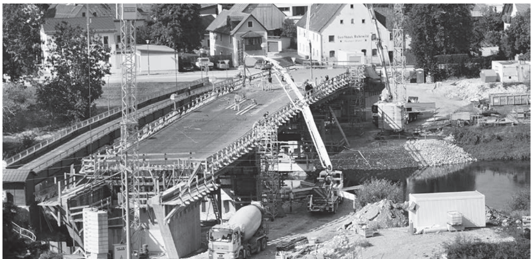
Ersatzneubau Naabbrücke, Duggendorf
