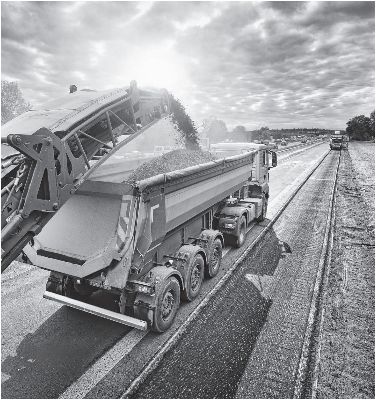
BAB 8 München–Salzburg, Deckensanierung
