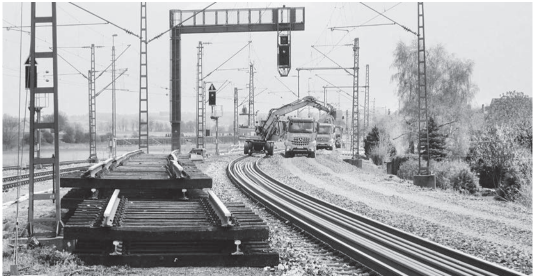
Gleiserneuerung Bahnhof Osterhofen
