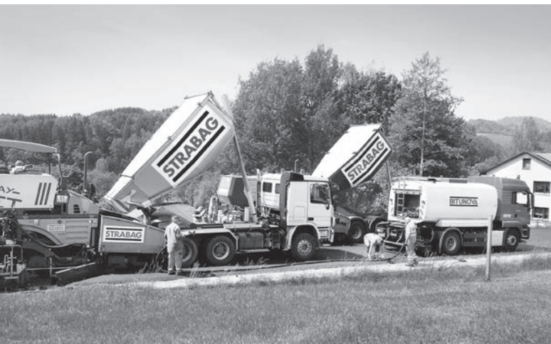
B 85 Augenthal-Eberhardsreuth, Asphaltarbeiten
