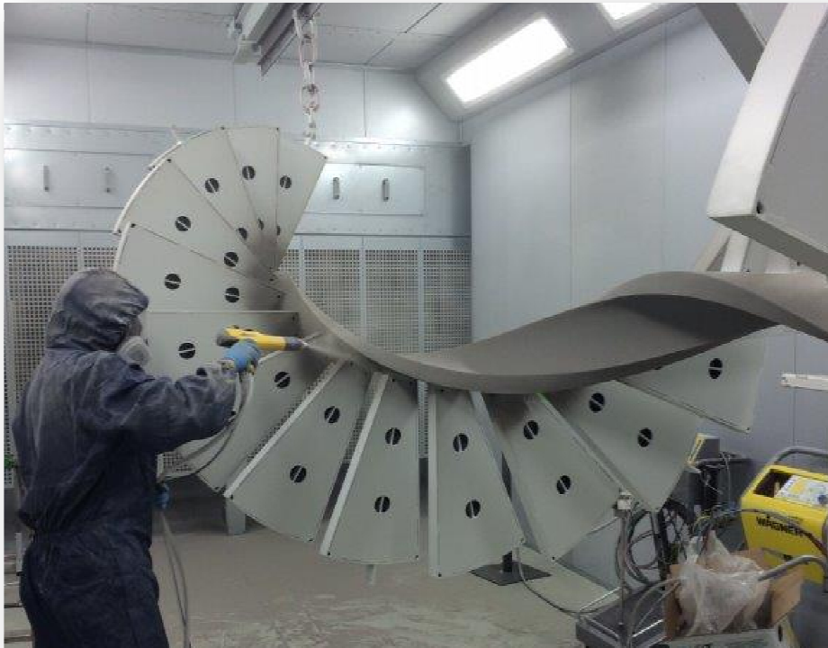
Pulverbeschichtung einer großvolumigen Wendeltreppe
