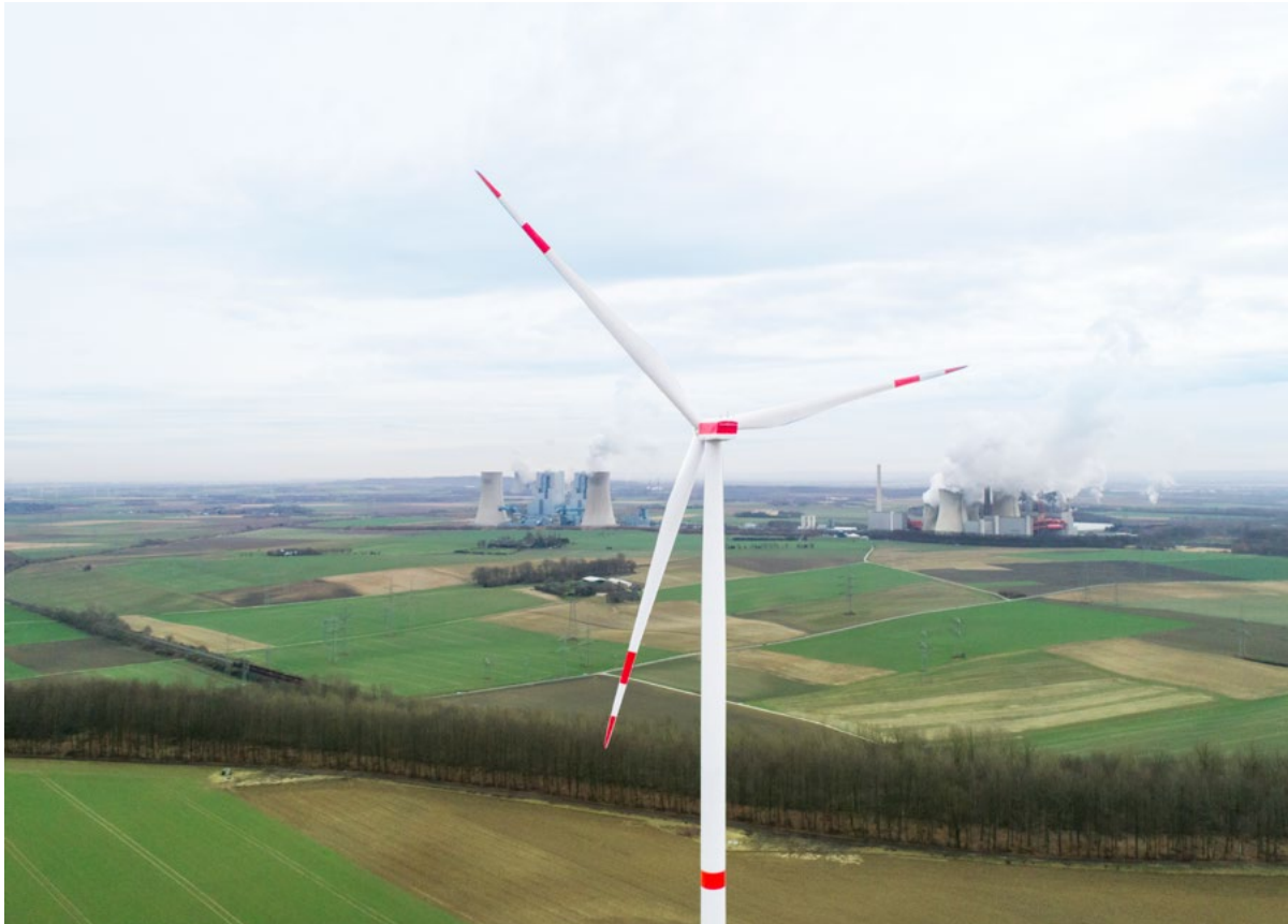
Moderne Technologie ersetzt die alte – die neue Windkraftanlage ist Teil des 2016 errichteten Repowering-Windparks auf einer stillgelegten Kohleabraumhalde bei Grevenbroich.
