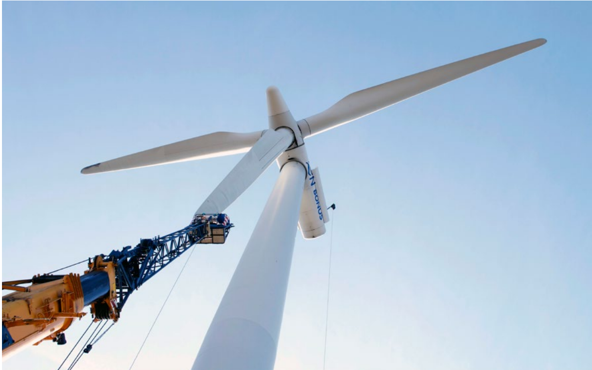
Die Montage der Rotorblattverlängerung, wie hier im portugiesischen Windpark Penedo Ruivo, erfolgt am hängenden Blatt ohne Demontage des Rotors – diese effiziente Methode spart Zeit und Geld.
