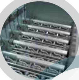
*Ein Filtration Rack mit insgesamt 224 m<sup>2</sup> aktiver Filterfläche für die Aufbereitung von ca. 2.100 m<sup>3</sup> Trinkwasser pro Tag*
