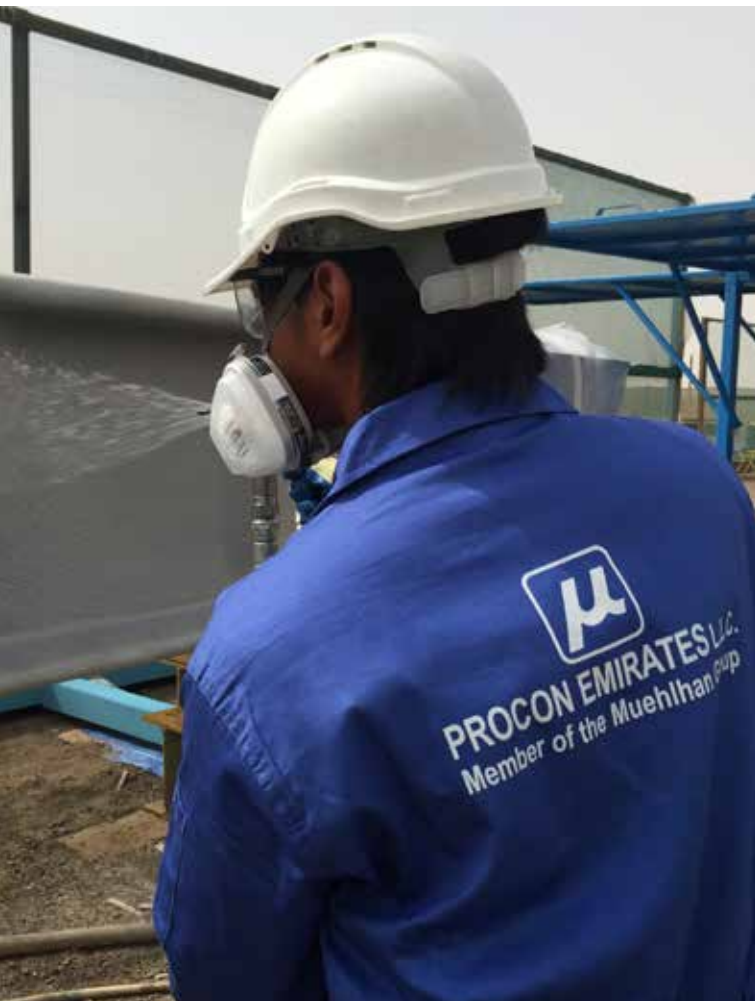
Aufbringen von Brandschutz auf Stahl
