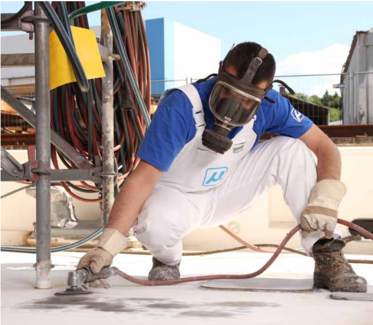
Muehlhan-Mitarbeiter schleift Stahlkonstruktion
