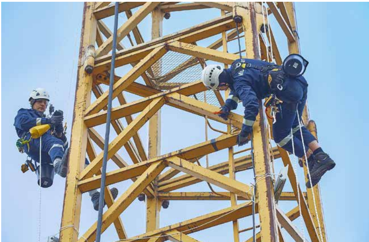
Zugangstechnik mit Seilkonstruktion
