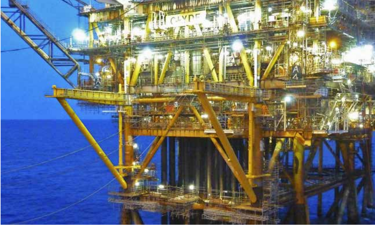
Ölförderplattform „Thistle“ in der Nordsee
