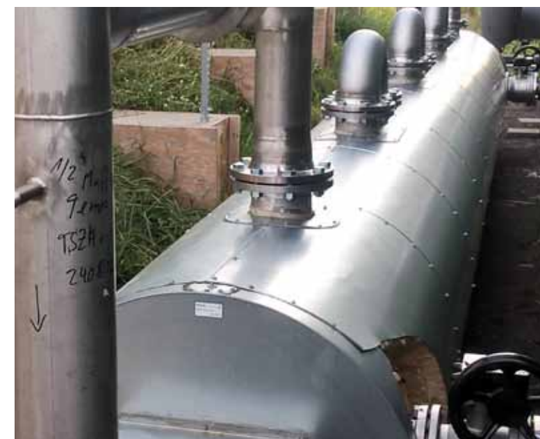
Allrounder mit Hochdruck: Die Thermodruckhydrolyse steigert die Gasausbeute um zehn bis über 60 Prozent und ermöglicht den Einsatz von Substraten, die bislang kaum für Biogasanlagen geeignet waren.
