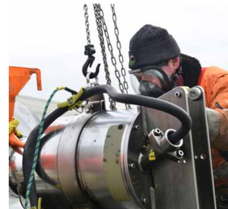
Fingerspitzengefühl und die richtige Arbeitsschutzbekleidung sind auch bei der Rührwerkswartung gefragt!
