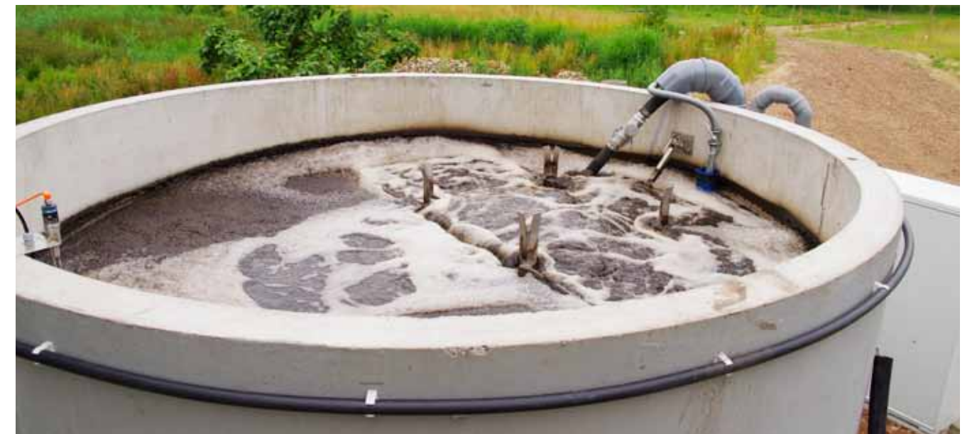
Herzstück jeder EnviClear-Anlage: Im Belüblungsreaktor sind Belüfler so angeordnet, dass sie kontinuierlich Luft in das Wasser leiten.
