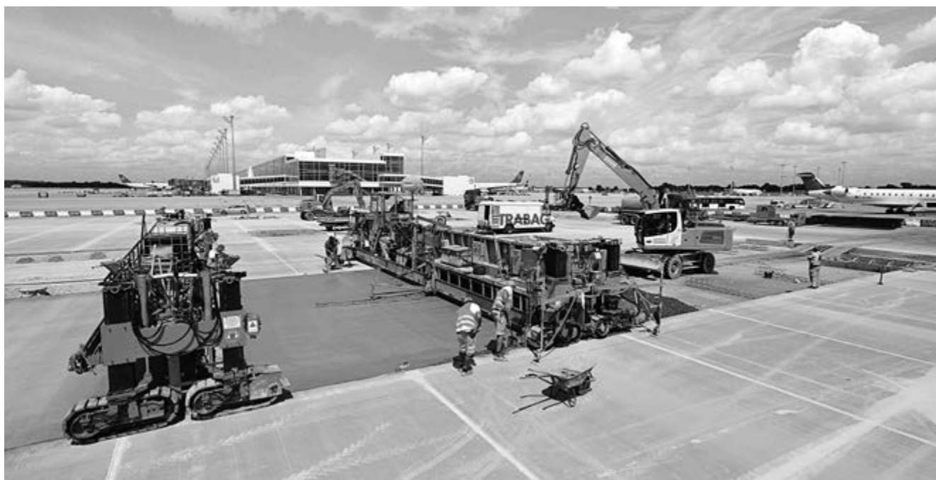
Flughafen München, Vorfeld 2, Flugbetriebsfläche in Betonbauweise
