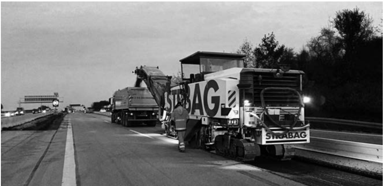
BAB 9 Holledau, Fräsarbeiten
