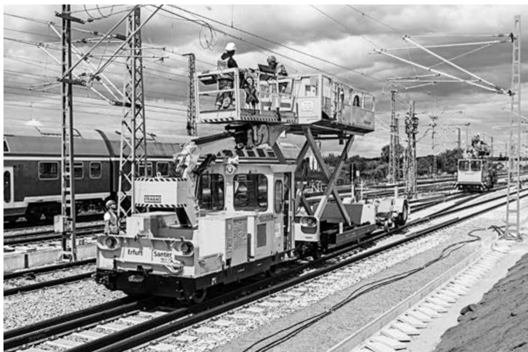
Bahnhof Halle (Saale), Fahrtdrahtziehkomplex Santer LBM4020
