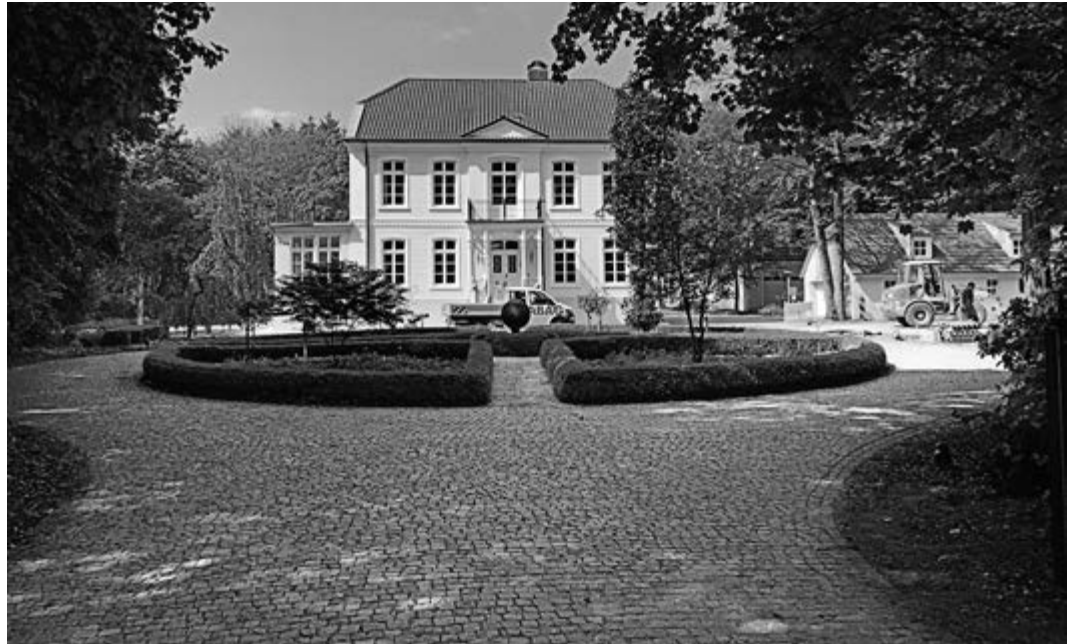
Gästehaus Enercon, Aurich, Pflasterarbeiten
