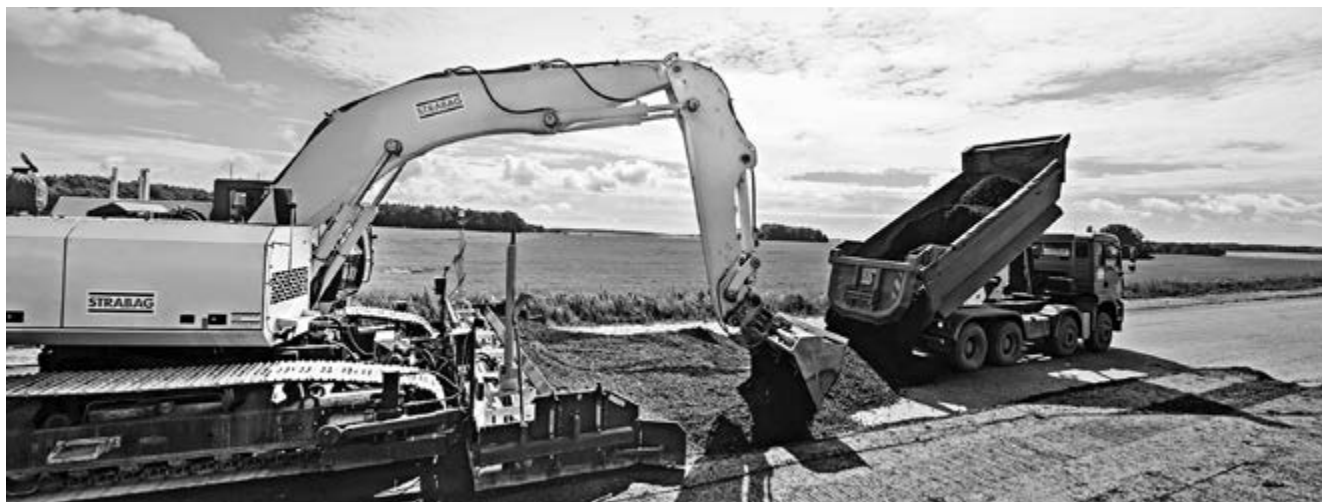
BAB 13 Radeburg–Dresden Nord, grundhafter Ausbau
