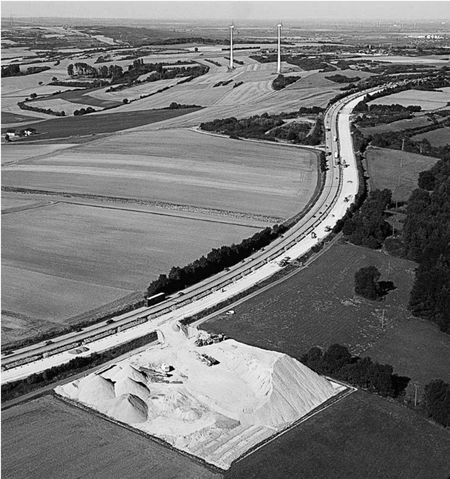
BAB 6 Wattenheim–Grünstadt, Grunderneuerung
