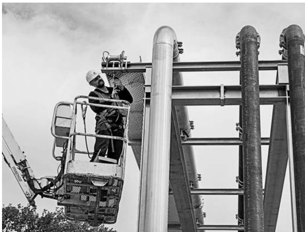
Klärwerk Hannover-Herrenhausen, Erneuerung der Anlagen zur Schlammbehandlung
