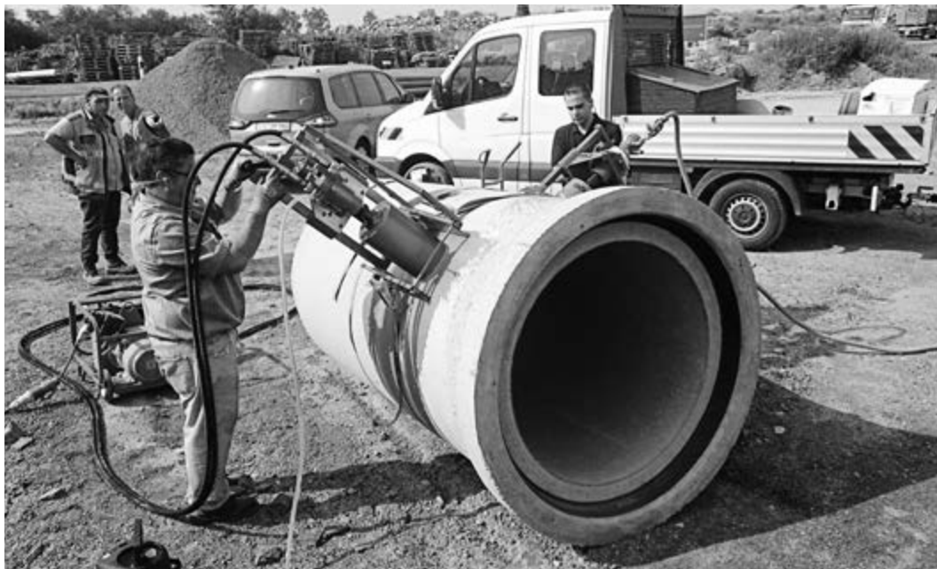
Schulungen und Einweisungen gehören zum Alltag auf unseren Baustellen
