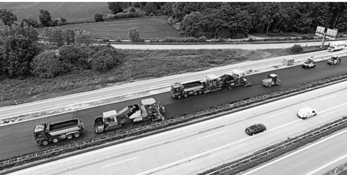
BAB 3 Autobahnkreuz Deggendorf, Fahrbahnerneuerung, Einbau Asphaltbinderschicht
