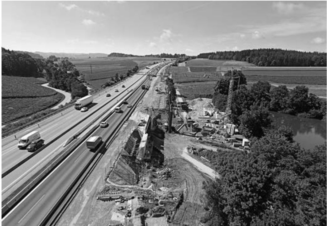
BAB 9 Nürnberg–München, Fahrbahnsanierung
