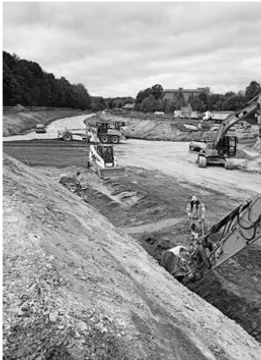
BAB 3 Weibersbrunn, Standstreifensanierung
