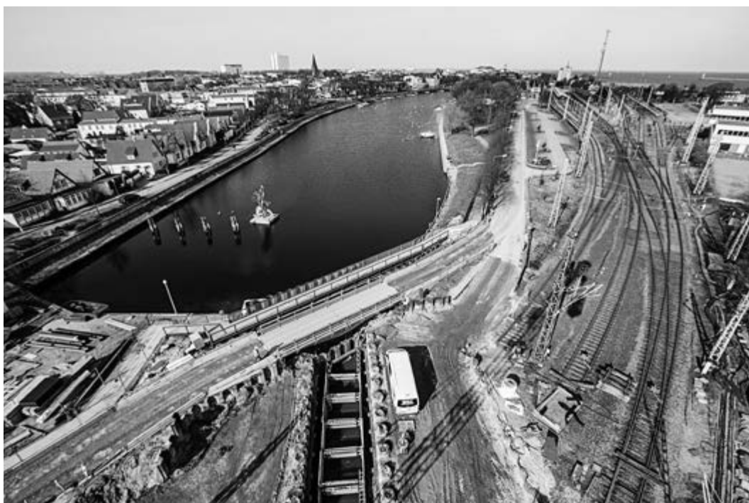
Stromgrabenbrücke Warnemünde, Erd- und Asphaltarbeiten
