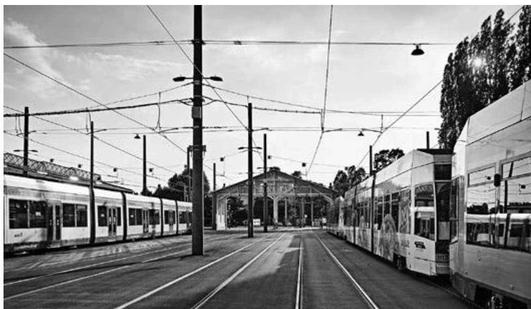
Umbau Straßenbahnbetriebshof Leipzig-Döllitz
