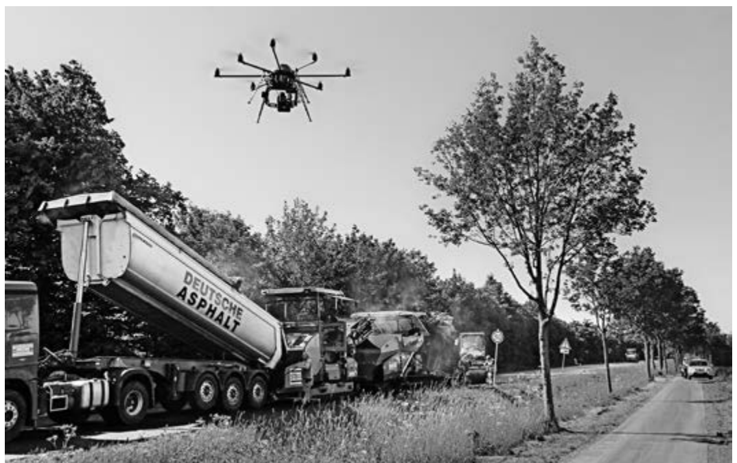
Von der Vermessung bis zur Dokumentation – Drohneneinsatz im Verkehrswegebau
