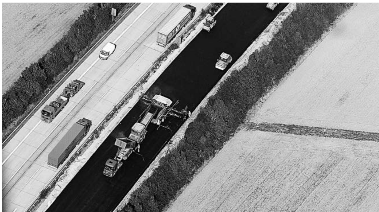
BAB 6 Wattenheim–Grünstadt, Grunderneuerung
