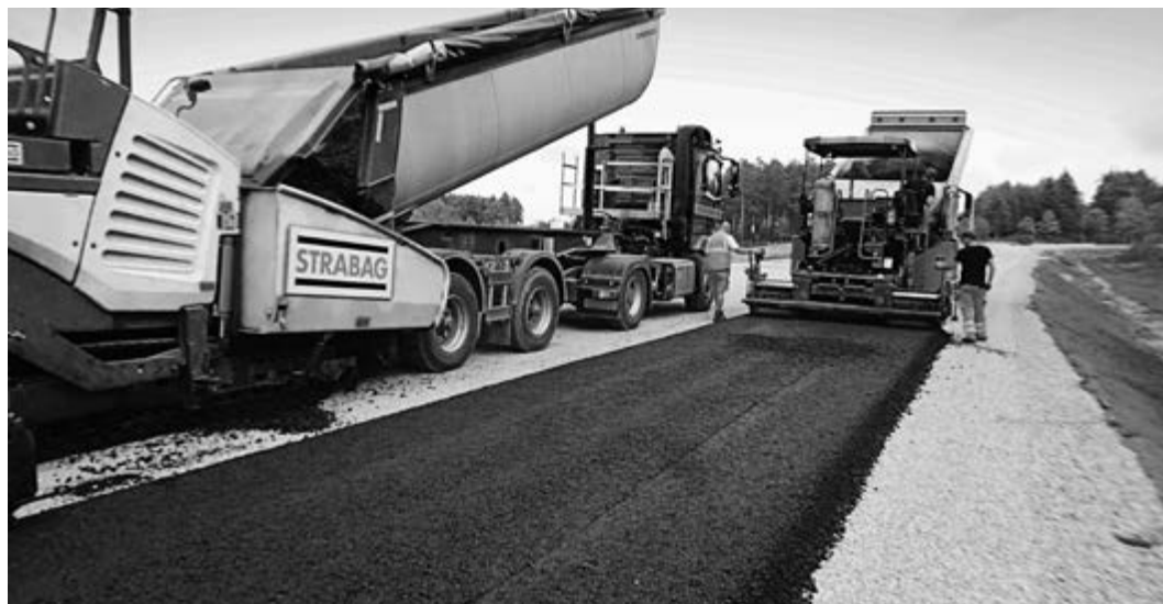
Erschließung Innovationspark Wackersdorf, Asphalttragschichteinbau
