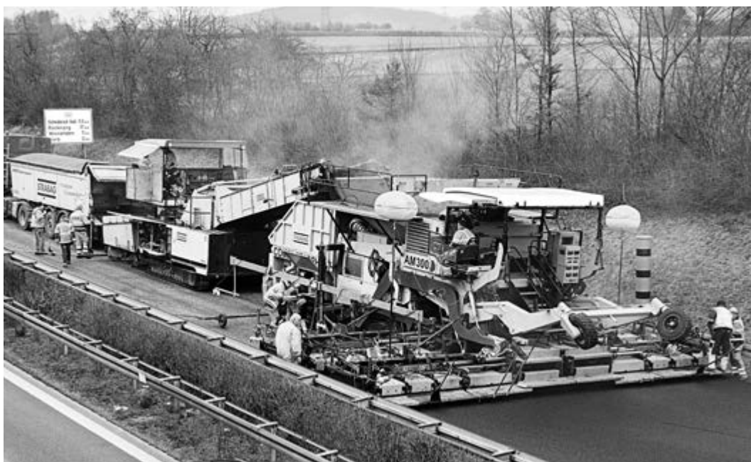
B 14 bei Waiblingen, Einbau von Kompaktasphalt
