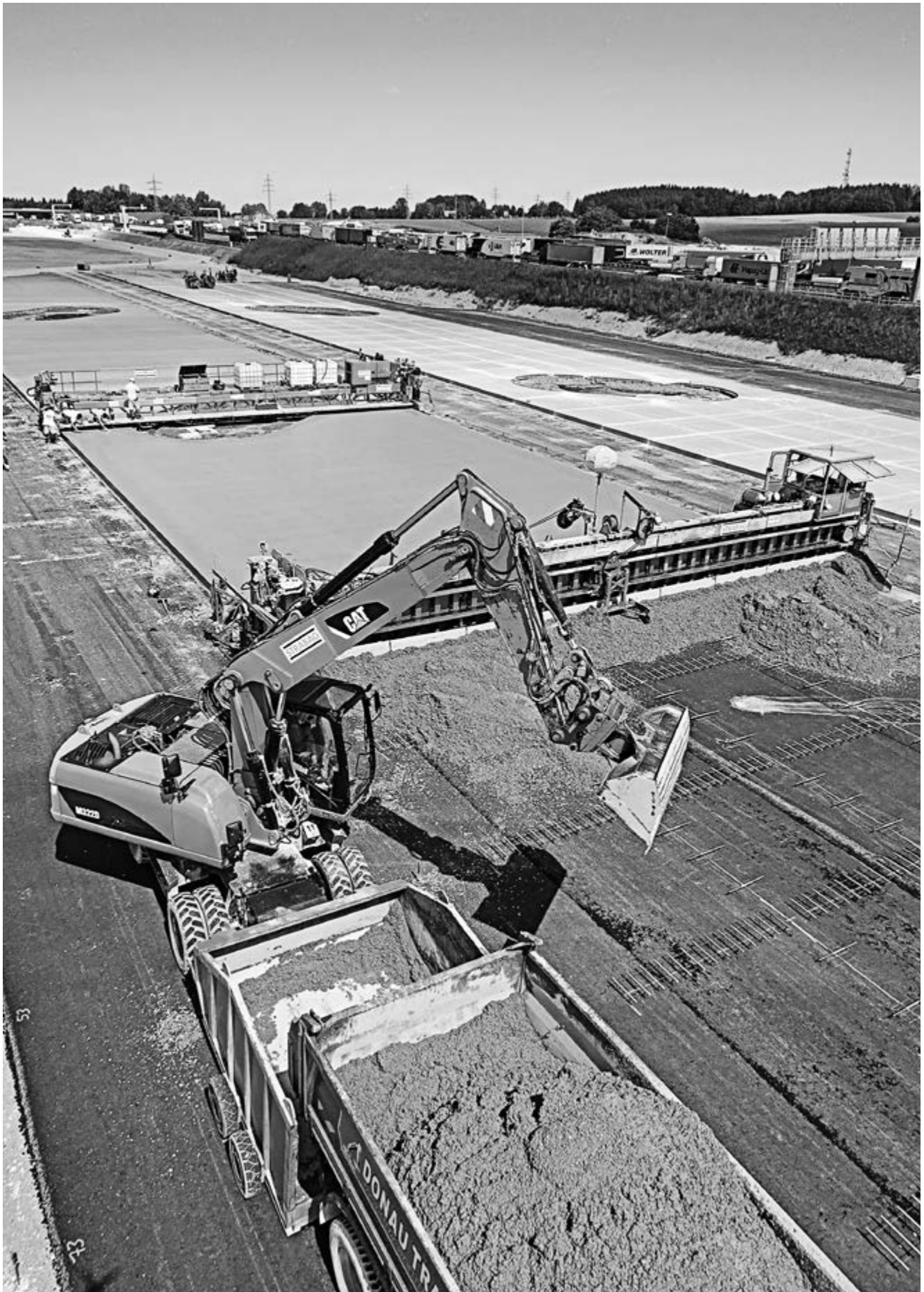
BAB 9 Tank- und Rastanlage Fürholzen, Herstellung einer Betonfahrbahn
