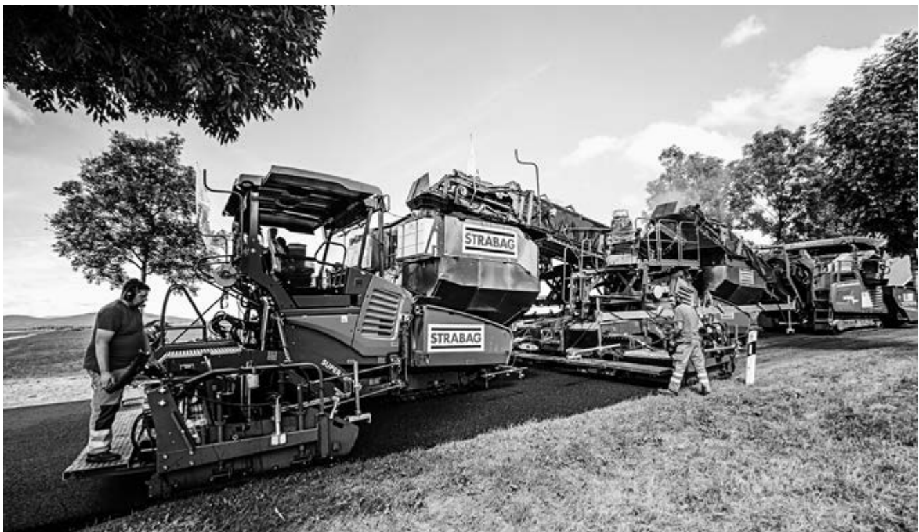
B 27 Königshütte–Rübeland, Deckensanierung
