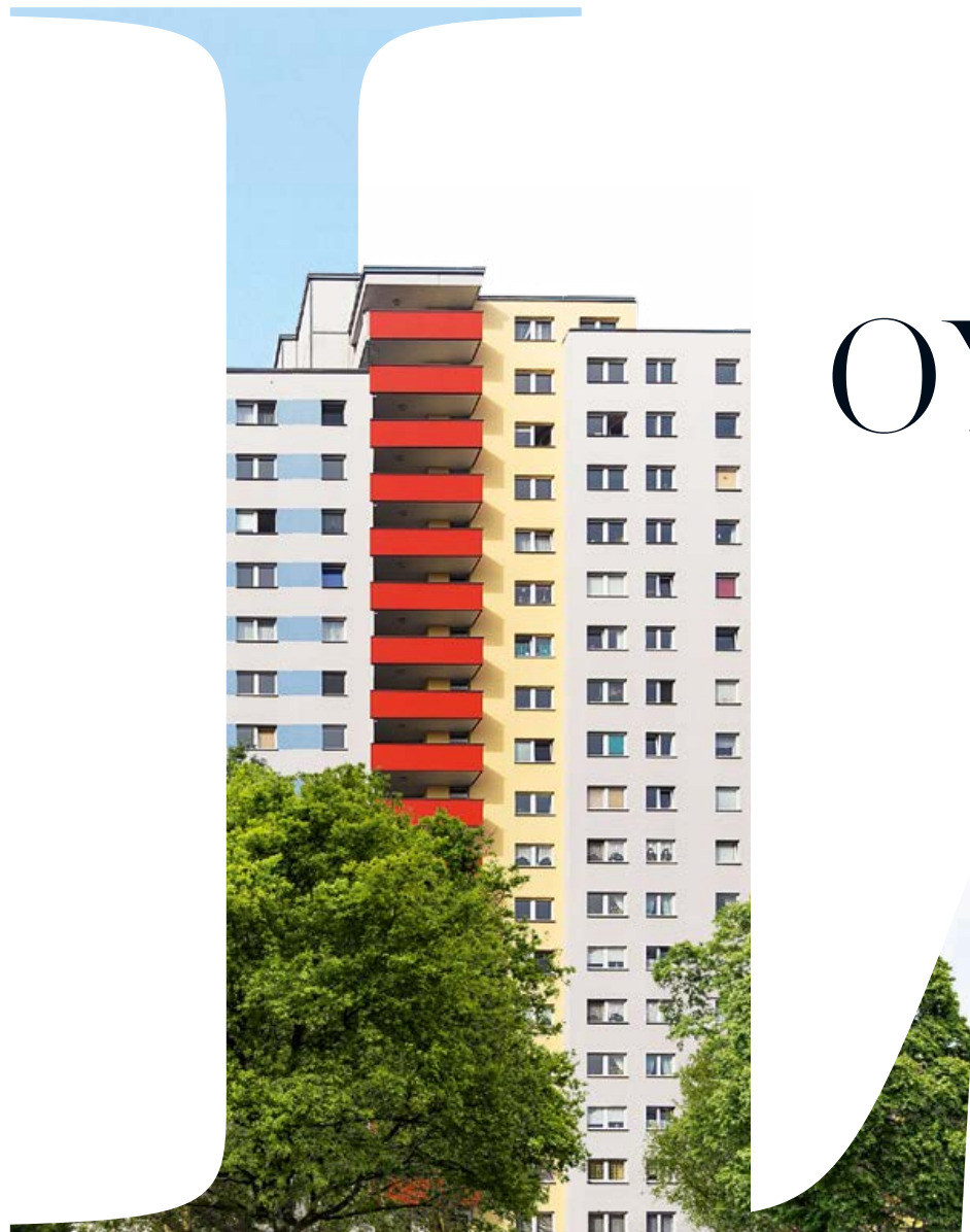
ADO-Gebäude – Bezirk Schöneberg – Feurigstraße (siehe Poster, Gebäude Nr. 4)
