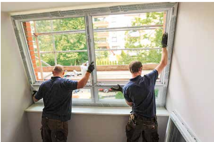
Just in time und passgenau – die Monteure bauen die neuen Fenster ein, sobald diese angeliefert werden.
