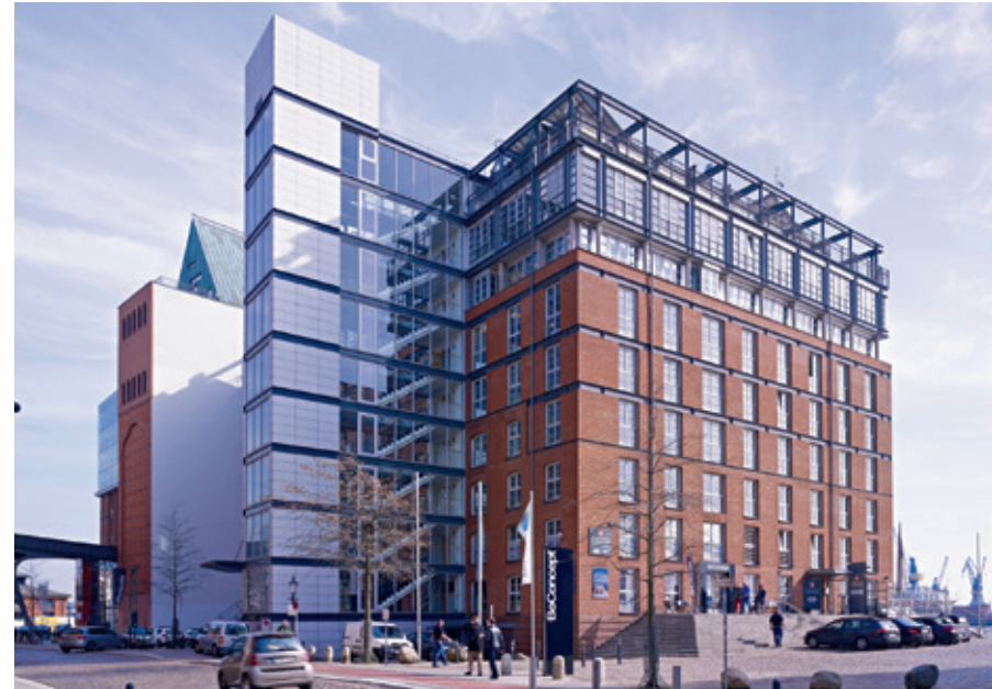
Das „GINN Hotel Hamburg“ mit über 132 Zimmern wird im Frühsommer 2017 auf vier ehemaligen Büroetagen eröffnen. In dem direkt an der Elbe gelegenen Speichergebäude befinden sich zudem Einzelhandels- und Büroflächen sowie ein Restaurant.
