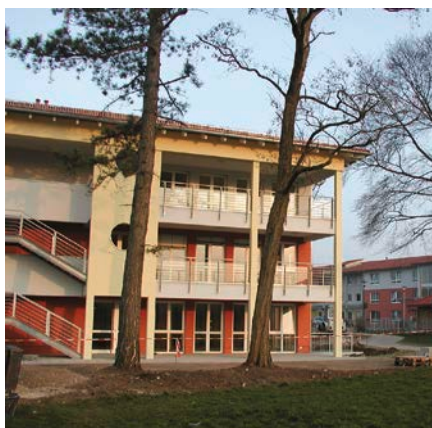
2003 und 2006: Errichtung des Pflegeheims Christian-Dierig-Haus.
