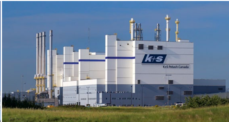
Der neue K+S-Standort Bethune in Kanada: Im derzeit modernsten Kaliwerk der Welt startete im Sommer 2017 die Produktion.
