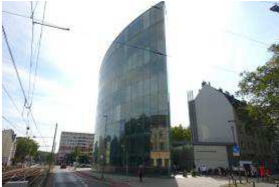
Ansicht von der Mülheimer Straße
