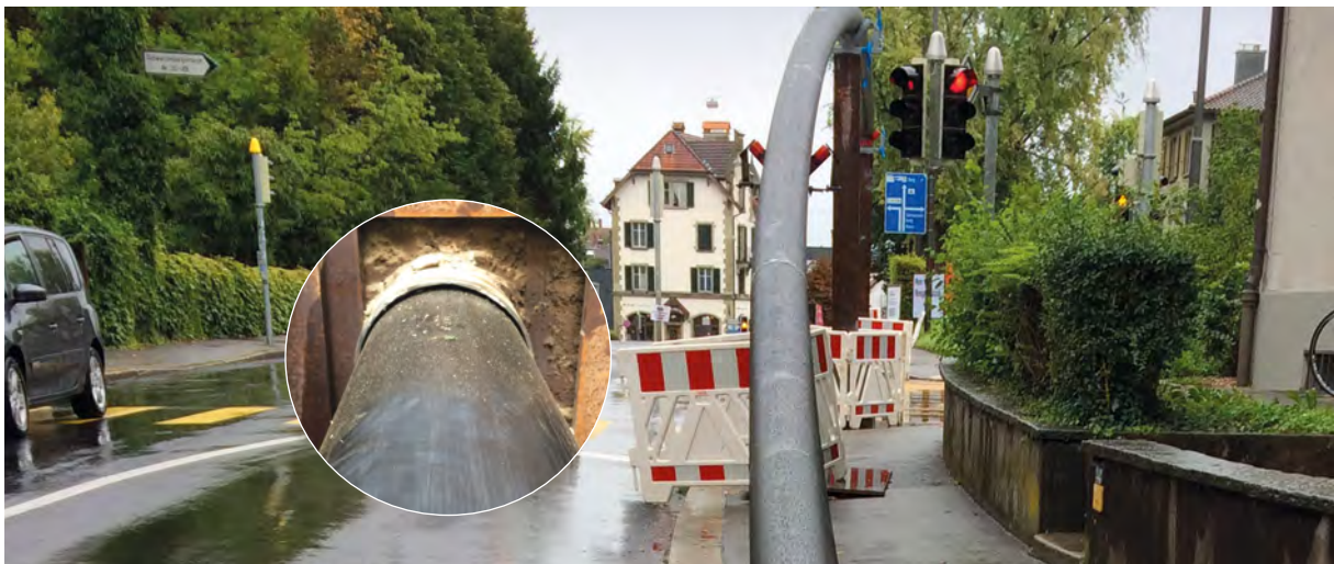
Der vorgeschweißte SIMONA® PE 100 Liningrohrstrang wird durch das konische Gesenk gezogen und somit der Querschnitt verringert. Durch die Elastizität des Materials dehnt sich der Rohrstrang wieder aus und legt sich passgenau an die Innenwand des Altrohres an.
