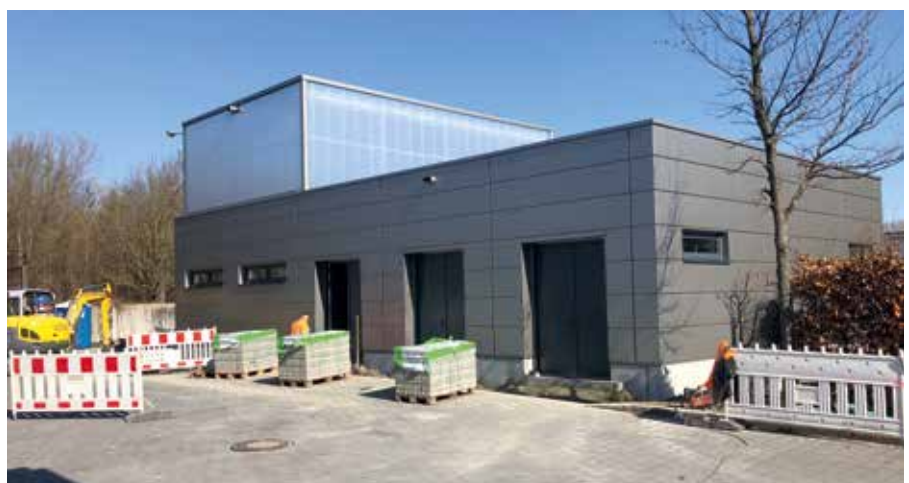
Ende Februar 2019 waren die Gründungsarbeiten am Büroloft (oben) abgeschlossen. Die Lagerhalle für die Braustätte und Gastronomie (unten) war derweil im Rohbau fertiggestellt.
