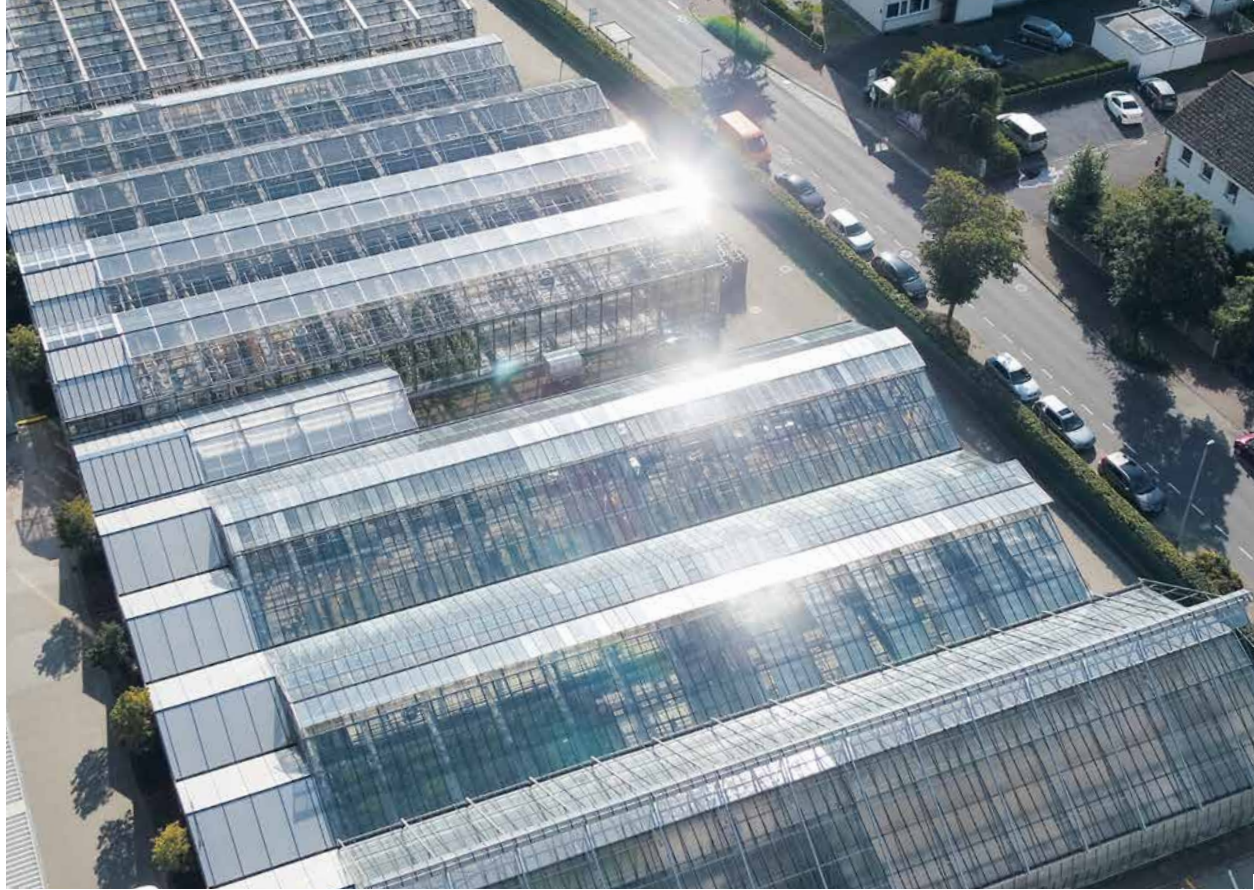
Neben Wärme benötigen Gewächshausflächen und Klimakammern auch Kälte. Am Standort Einbeck wird diese seit kurzem von einer neuen Kältezentrale geliefert, die für eine effizientere Energiegewinnung und eine bessere Energieverteilung über das Betriebsgelände sorgt.
