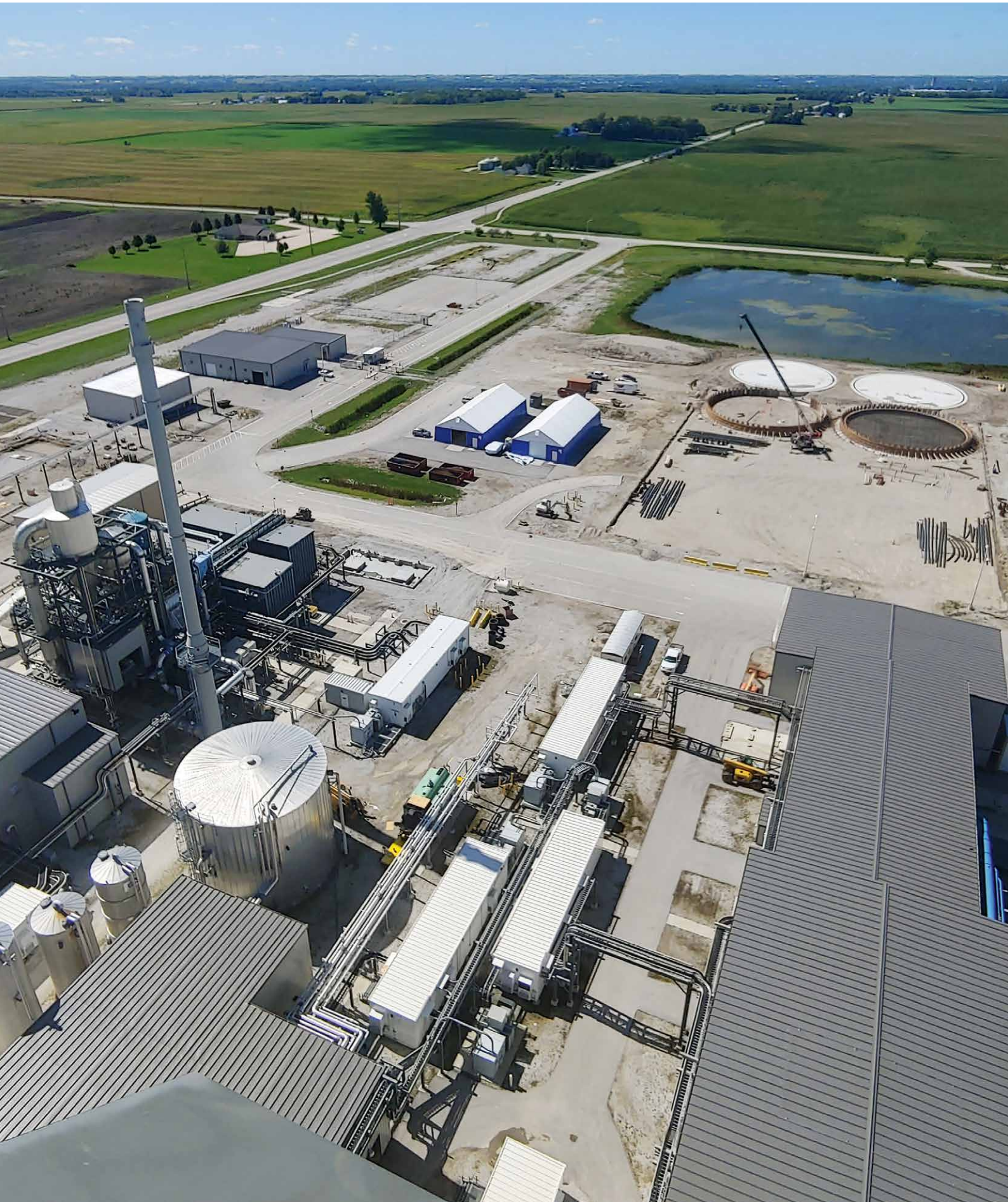
Im Bau: Stroh-Biomethan-Anlage am VERBIO Standort in Iowa, USA
