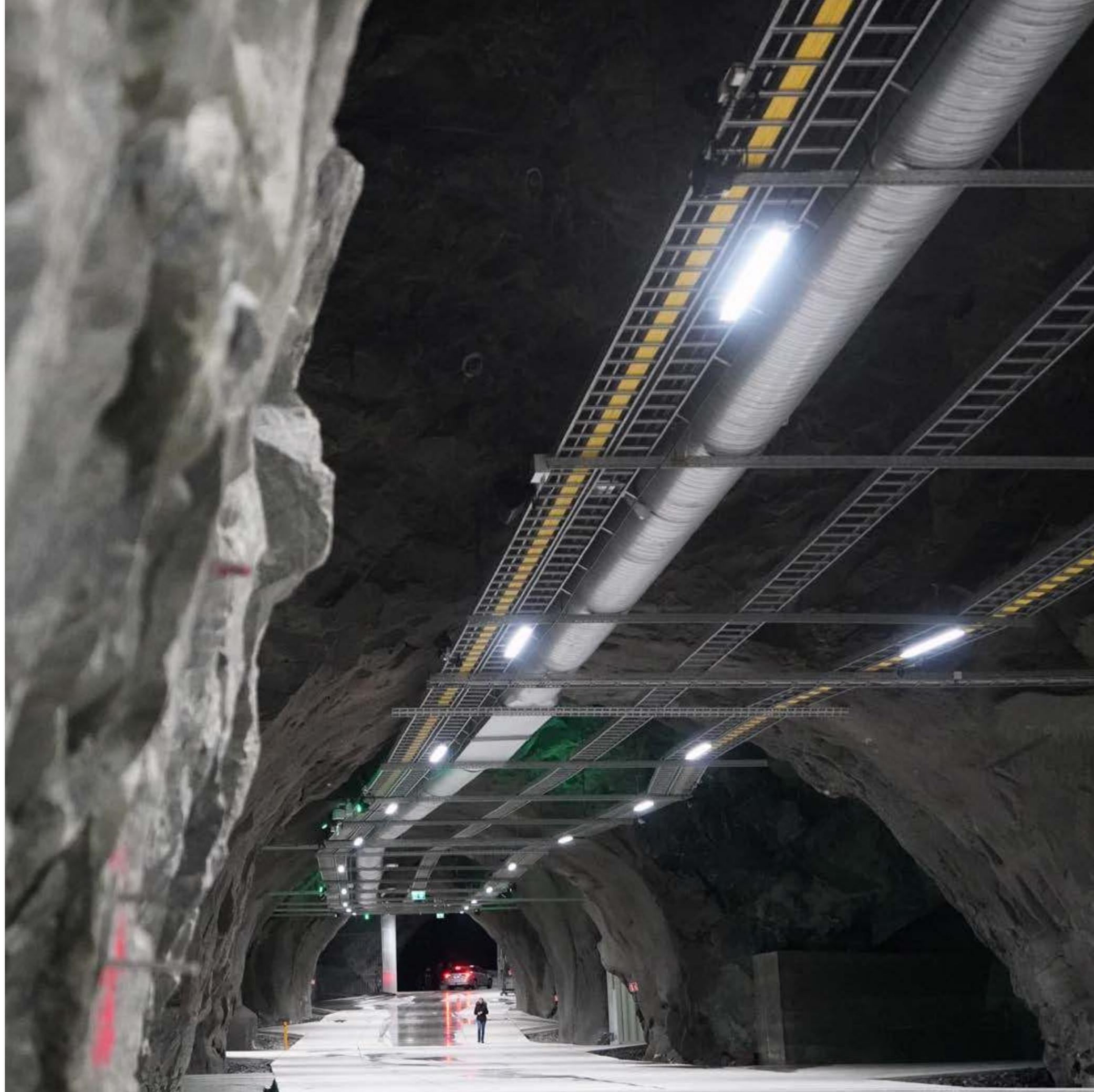
Tief in den Berg führt die 1.300 Meter lange Zufahrtsstraße – 14 Meter breit und fast 4 Stockwerke hoch. In der ehemaligen Olivin-Mine arbeiten die Mining-Containern der Northern Bitcoin AG.
