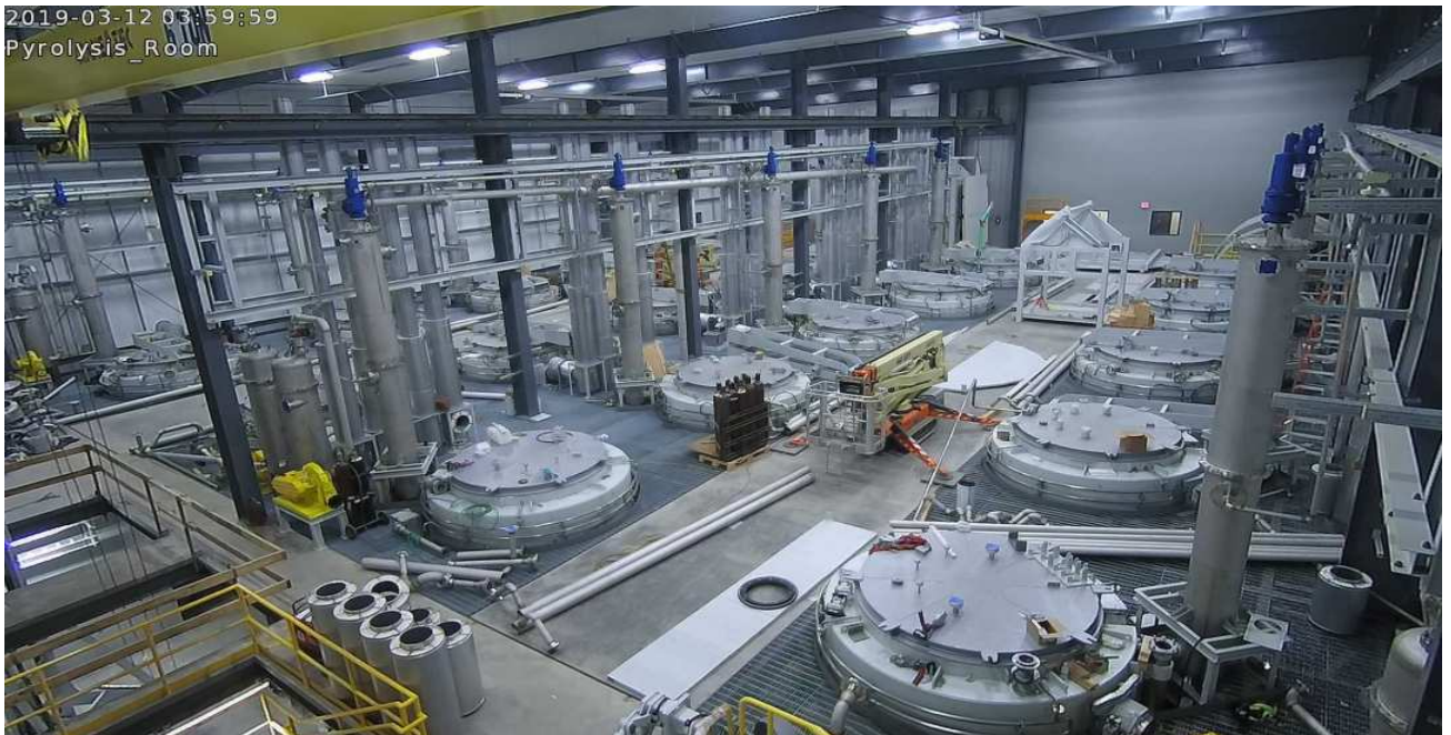
Der Produktionsstandort von Pyrolyx in Terre Haute (US-Bundesstaat Indiana), der zurzeit errichtet wird; März 2019.
