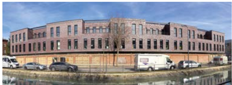
Die Bürolofts am Proviantbach waren schon bei Baubeginn vermietet.
