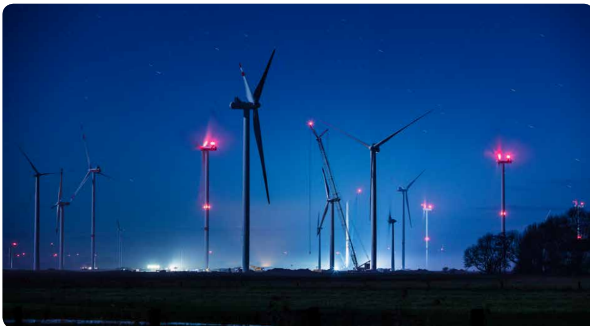
EFOY Pro Brennstoffzelle sichert Stromversorgung für Hindernisbefeuern der Windanlagen.
