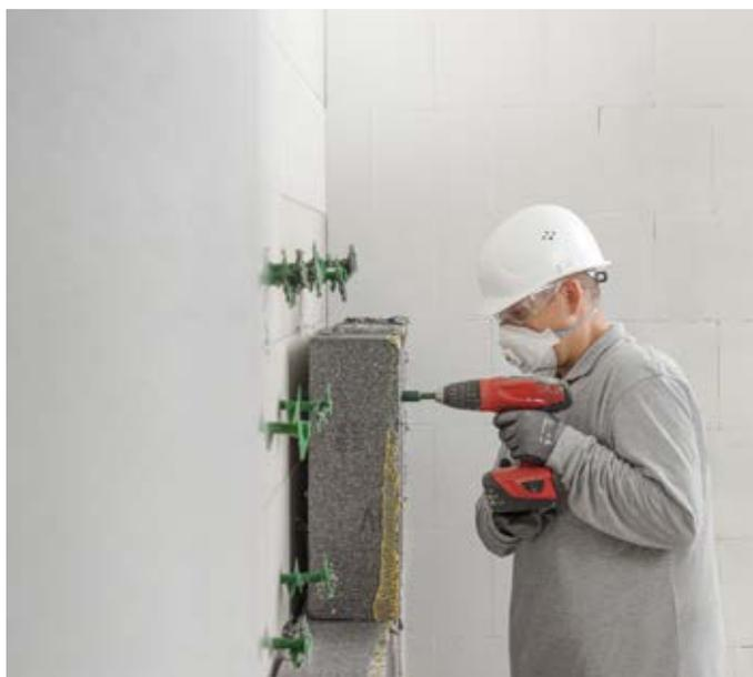
Einen Fokus legte die Forschung & Entwicklung auf die Recyclingfähigkeit: Mit dem Dämmplattenbefestiger StoFix Circonic können Fassadendämmsysteme ganz ohne Klebemörtel befestigt und beim Rückbau sortenrein getrennt werden.
