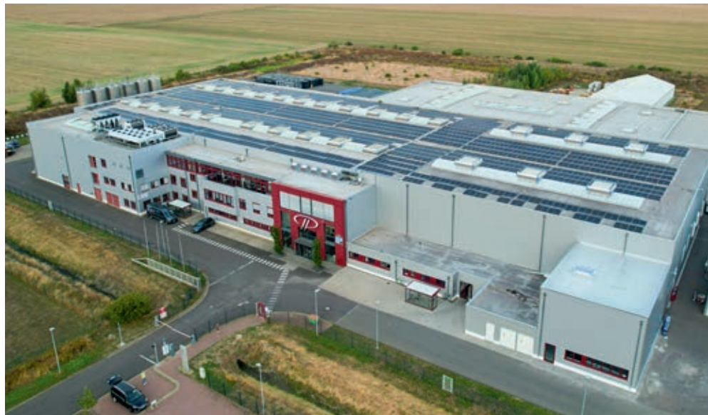
Die Photovoltaikanlage am deutschen POLYTEC-Standort Wolmirstedt liefert eine Leistung von 614 kWp.
