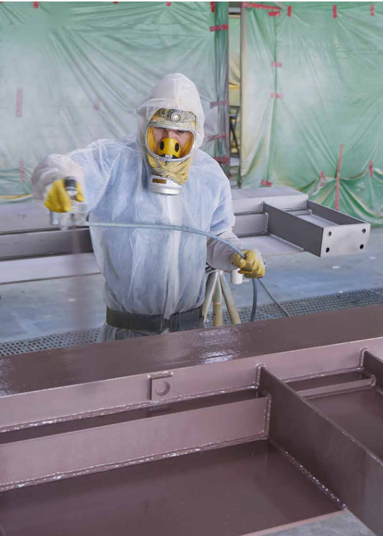
Aufbringen von Oberflächenschutz auf eine Stahlkonstruktion
