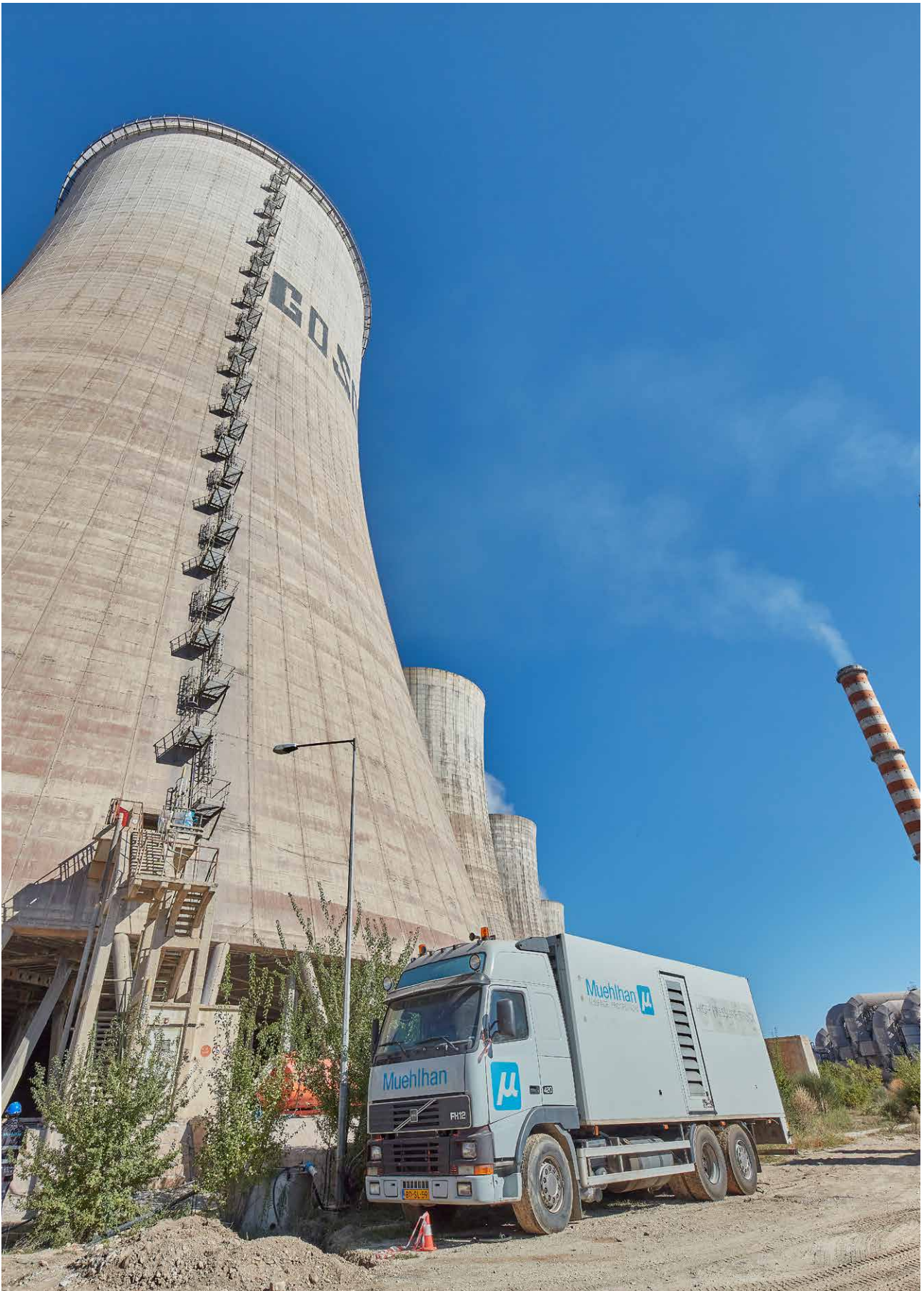
Arbeiten an einem Kühlturm in Griechenland
