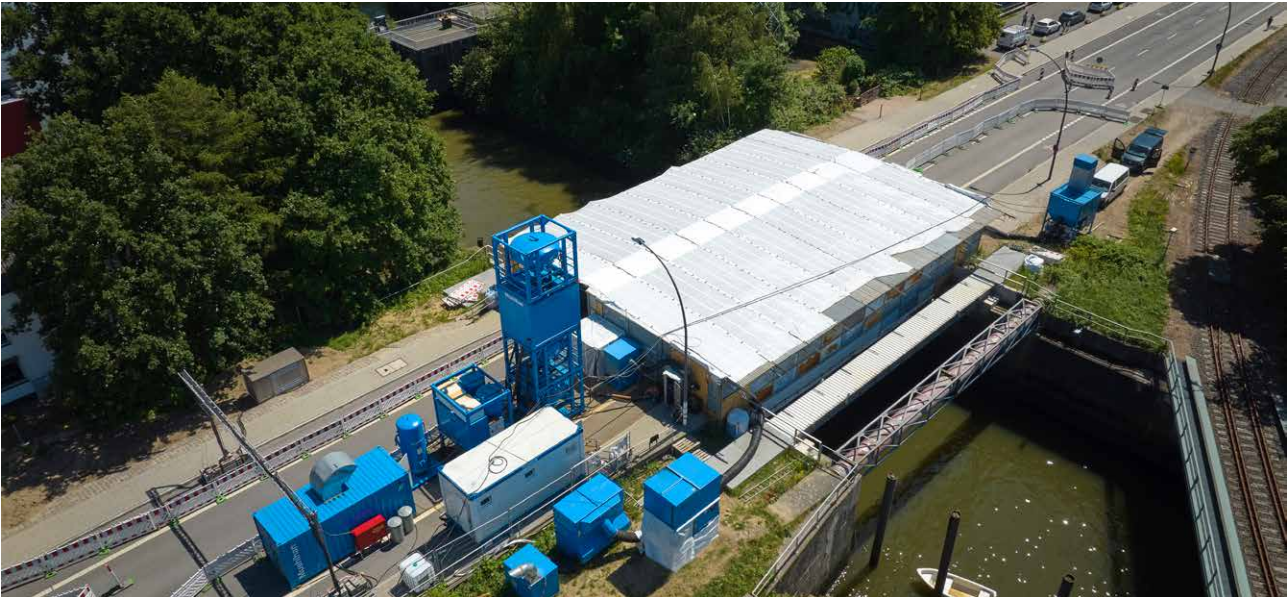
Instandsetzungsarbeiten an einer Brücke
