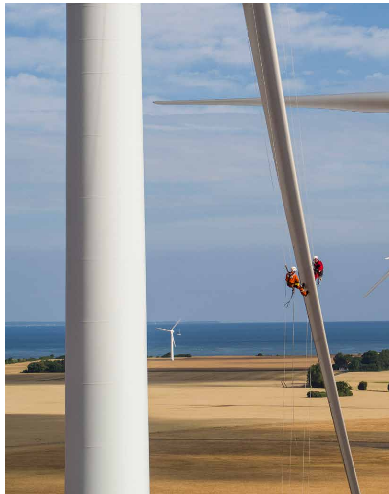
Prüfung von Beschichtung an Windkraftanlage
